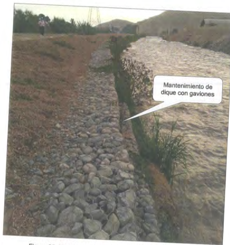
Figura 35. Mantenimiento de dique con gaviones
