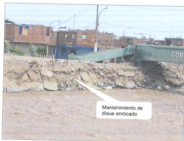
Figura 34. Mantenimiento de dique enrocado
