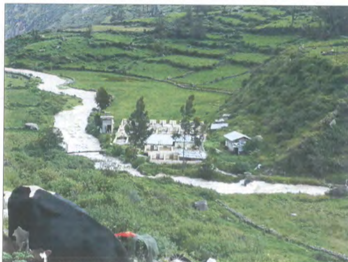
Figura 7. Captación directa para una piscigranja, inundación y sedimentación de las pozas del criadero de peces
