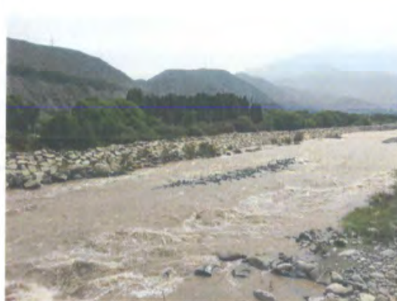
Figura 10. Construcción de defensa con roca grande acomodada, construida en tramo recto del curso del río, donde tiene mejor comportamiento a la fuerte velocidad de arrastre y contención
