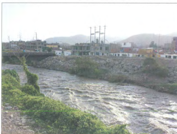
Figura 9. Tramos de defensa con piedras al volteo cuyo fin es evitar la erosión lateral
