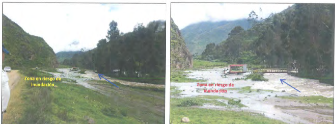
Figura 2. Carretera Carabaylo-Canta y piscigranja en riesgo de inundación
