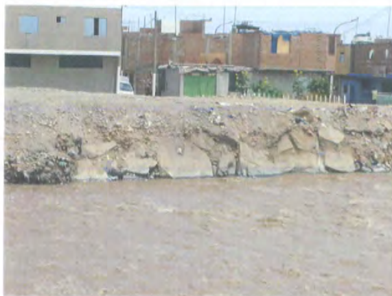
Figura 10. Construcción de defensa con roca grande acomodada, construida en tramo recto del curso del río, donde tiene mejor comportamiento a la fuerte velocidad de arrastre y contención
