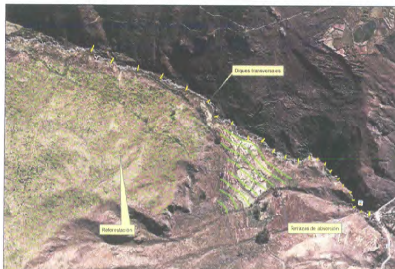
Figura 39. Obras de control y conservación de suelos
