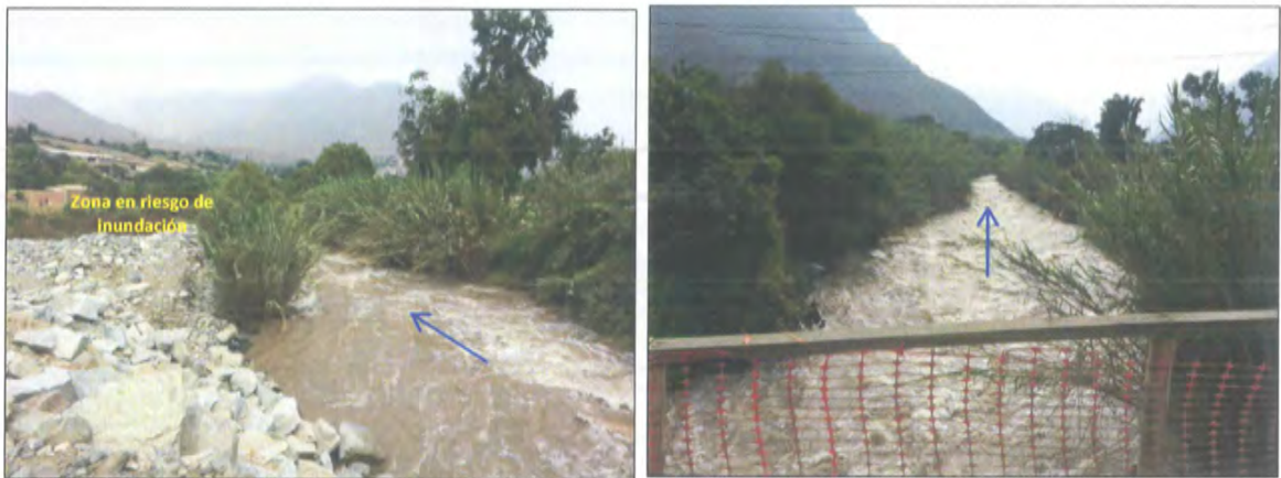
Figura 3. Puente Yangas en riesgo y áreas de cultivos
