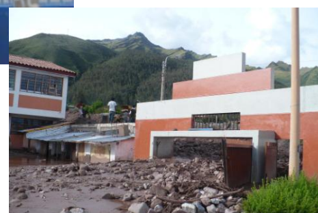
Centro de Salud e Institución Educativa en las márgenes de la quebrada Ramoschaca
