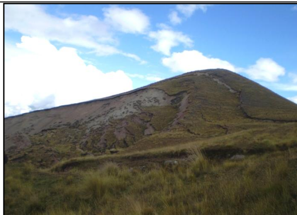
Deslizamiento del Cerro Llamacancha
