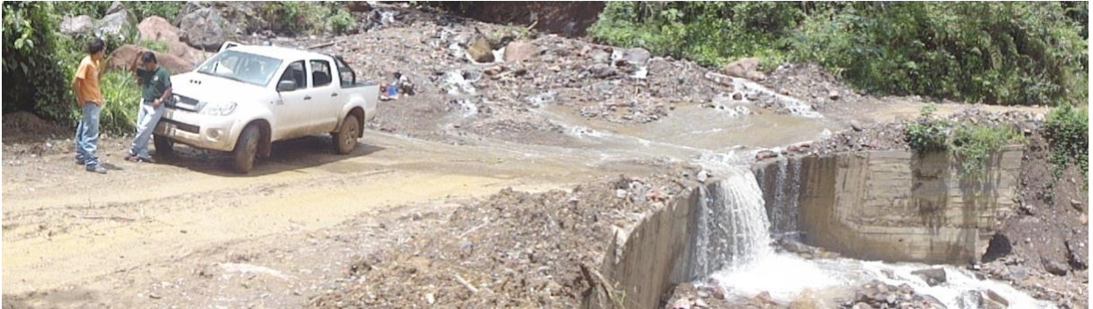
Foto 18.- Quebrada Chungaryhuayco, generó flujo de detritos que afectó carretera Sivia-Balsamuyocc.
