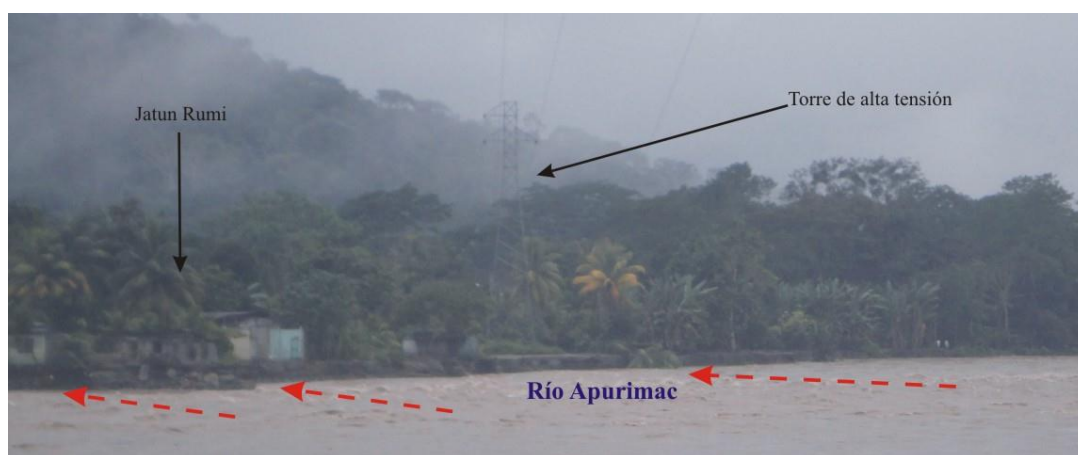
Foto 16.- Torre de alta tensión que puede ser afectada por la erosión fluvial.
