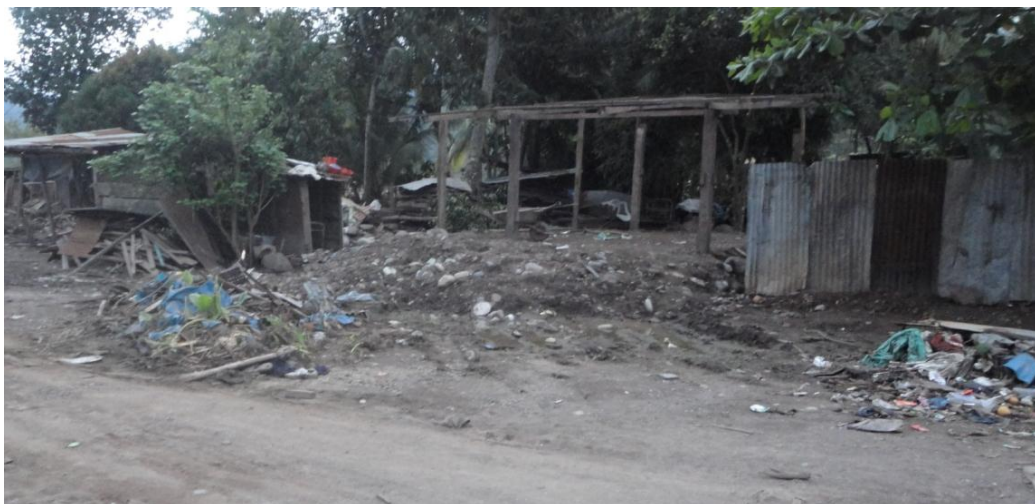
Foto 25.- Área urbana, viviendas afectadas por el huayco e inundación.
