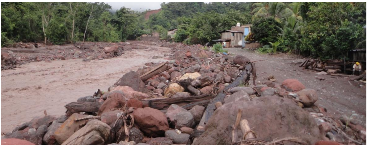
Foto 21.- Aguas arriba del puente, de donde se empieza a ampliar la quebrada.
