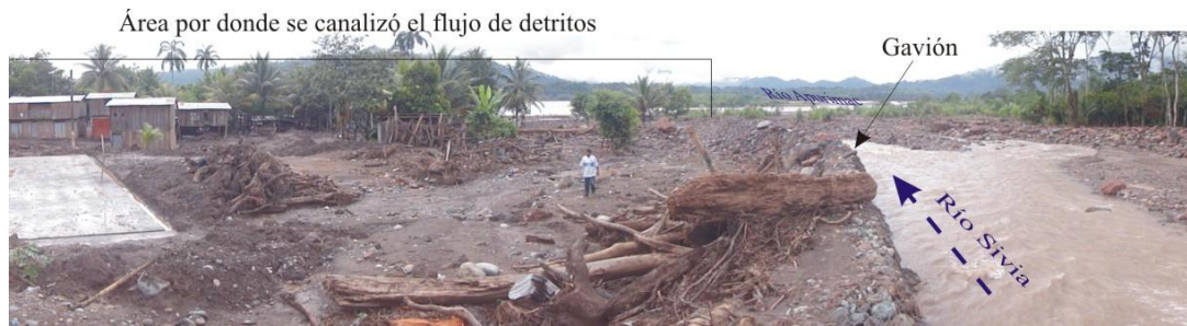
Foto 23.- Gavión ubicado en la margen izquierda del río Sivia, cubierto por restos de troncos de árboles.
