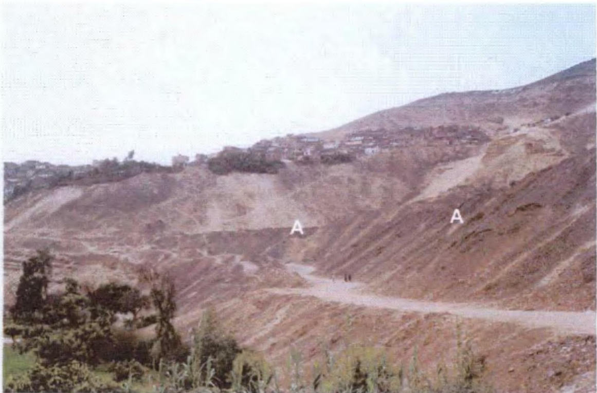
FOTO N° 4: Vista de la vía de acceso a la 6ta. Zona del A.A.H.H. 07 de Octubre, donde se observa material de desmonte en el borde externo (A).
