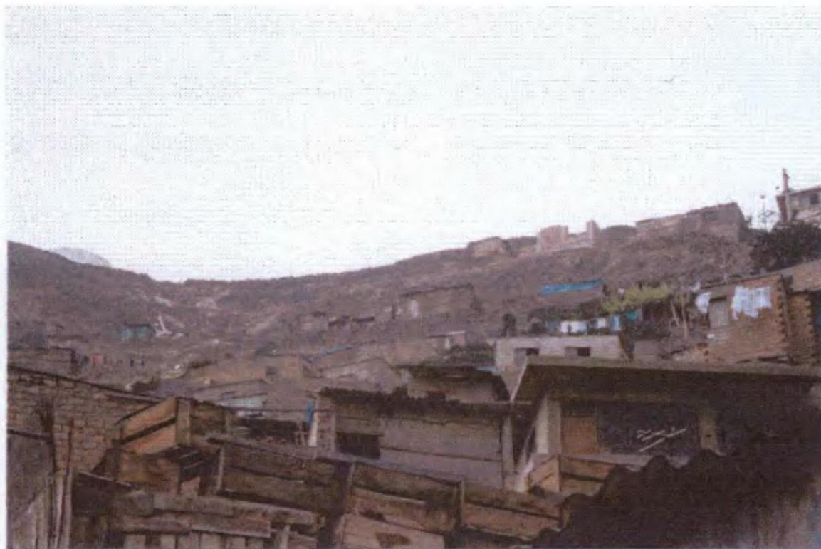
FOTO N° 7 : vista de la zona N° 3, donde hay edificaciones de material noble sobre la roca, pero también existen edificaciones precarias construidos sobre material de relleno.
