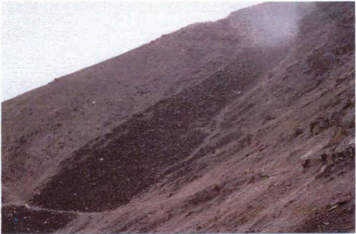
FOTO N° 3: Apréciese, la zona de canchales, conformado por material anguloso suelto.
