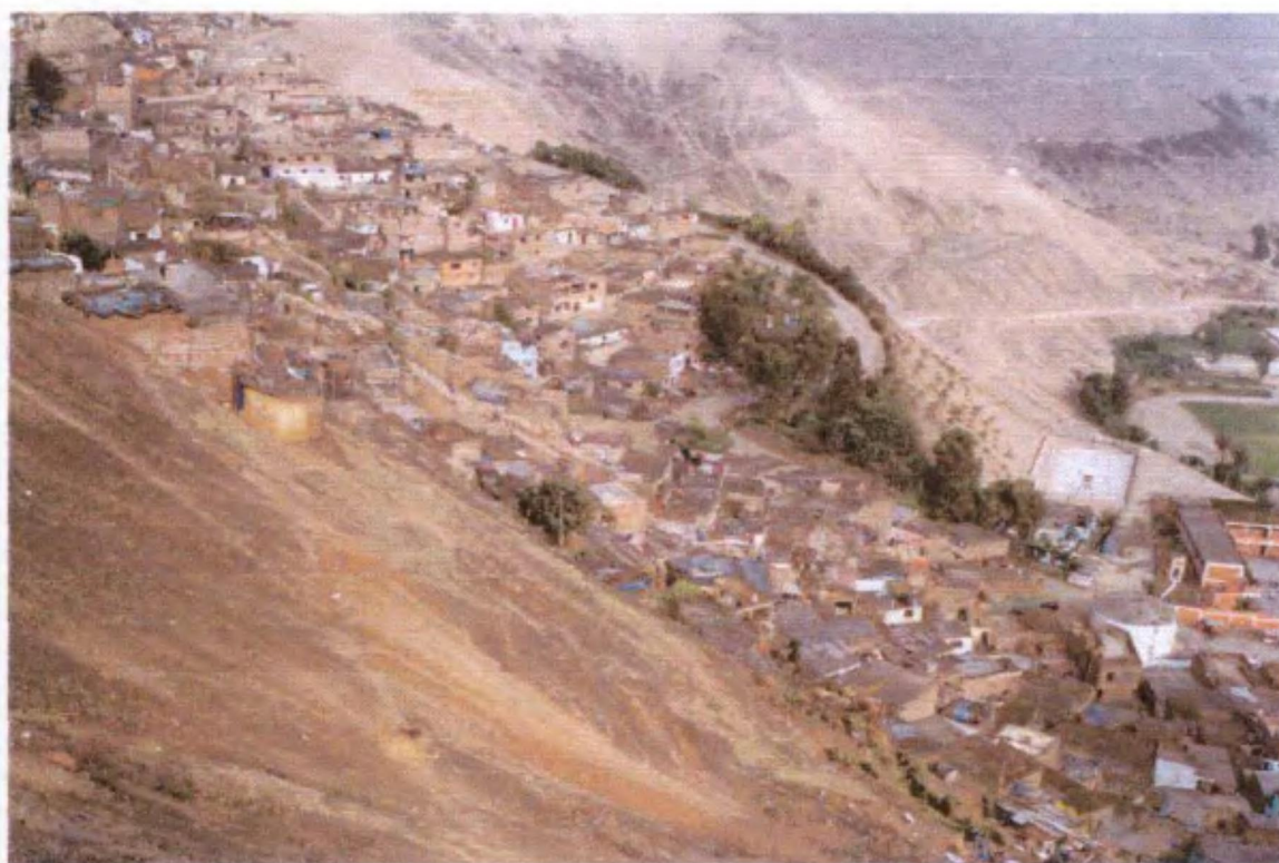
FOTO N° 8 : Zona 4, donde la pendiente de la ladera es muy fuerte, se observan pocas viviendas, algunas de ellas construidas sobre material de relleno.
