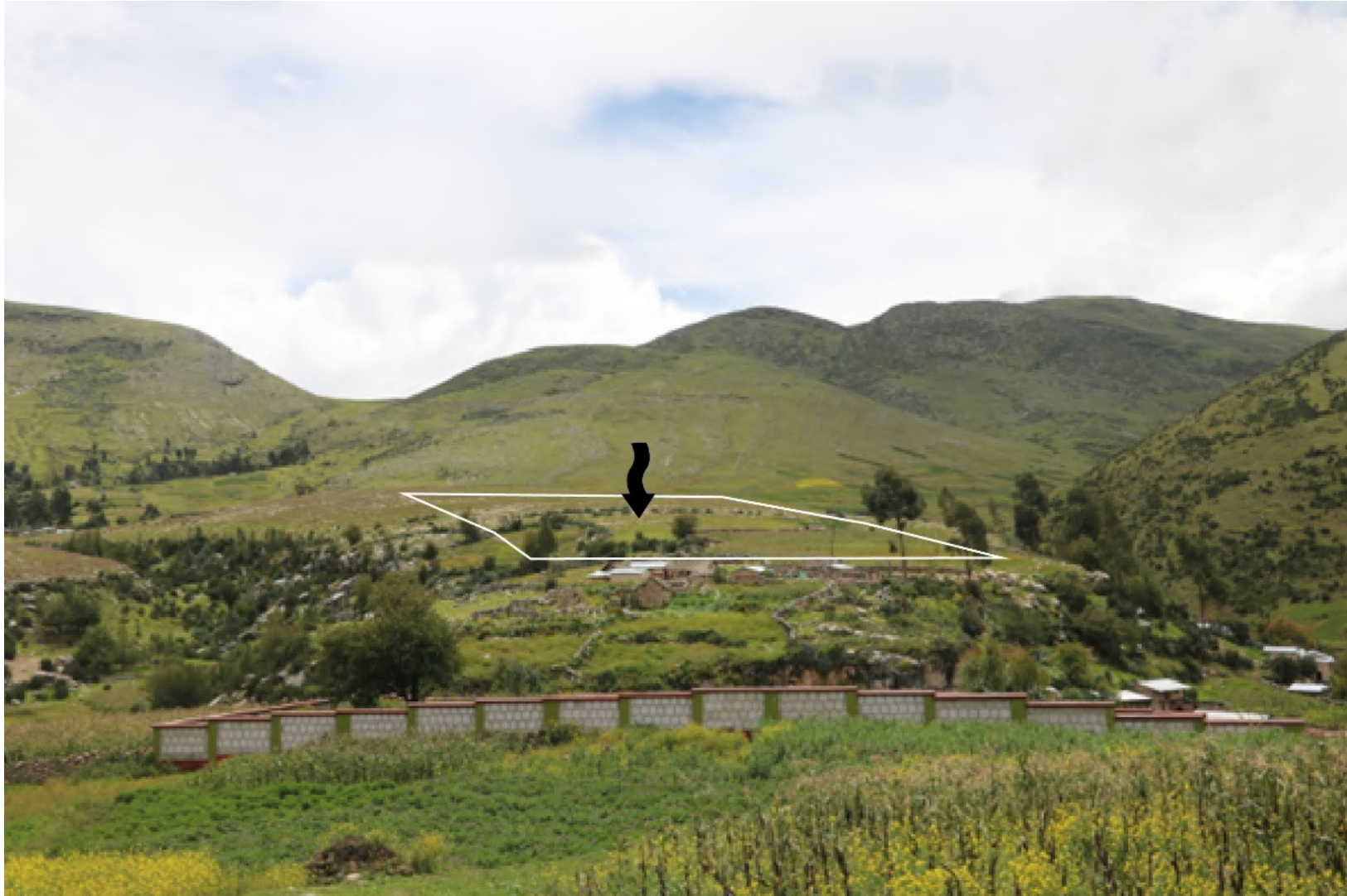
Fig. 20. Vista al oeste del deslizamiento. Zona (cuadro blanco con flecha negra) donde se sugiere el reasentamiento de las viviendas afectadas (opción 1 de la figura 17).
