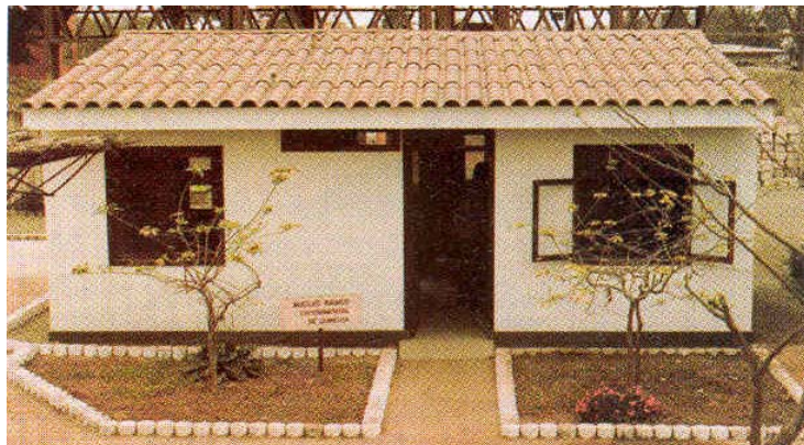
Fig. 6.6. Casa modelo de quincha construida en ININVI.
