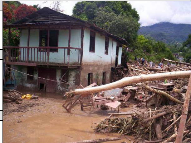
Afectación producida por la Qda, Huacará 22/01/2007
