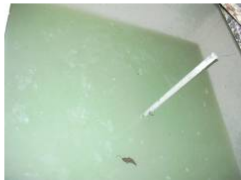
Foto N° 23 : Dosificador de carga variable
