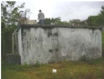
Foto N° 31 : Reservorio Nueva Vista
