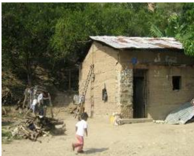
Foto N° 6: Vivienda típica en centros poblados rurales
