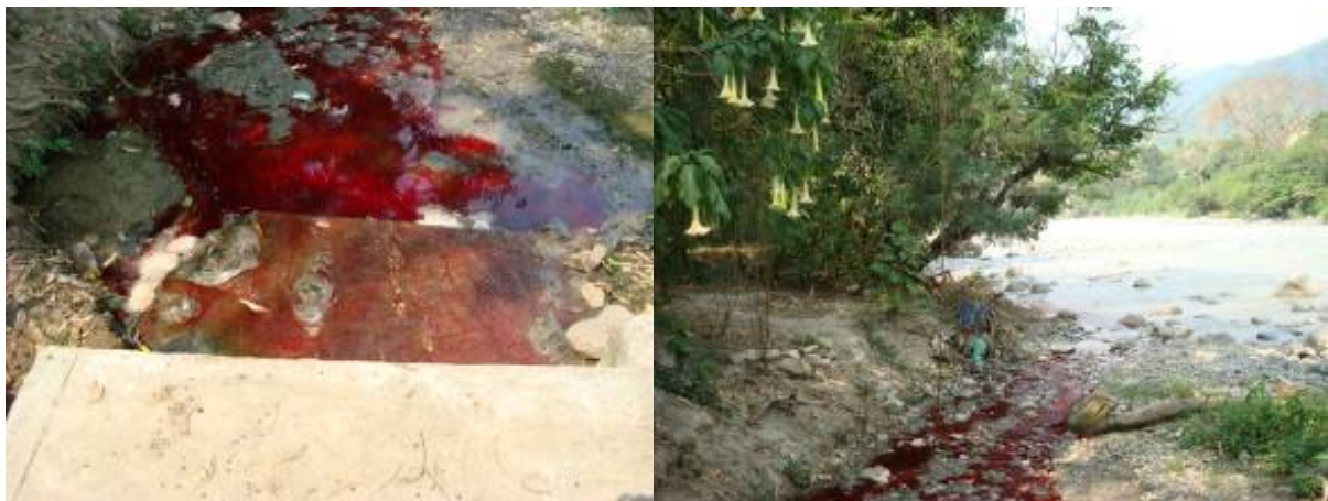
Fotos N° 68 y 69 : Emisor del Camal Municipal al río Tulumayo – margen izquierda.
