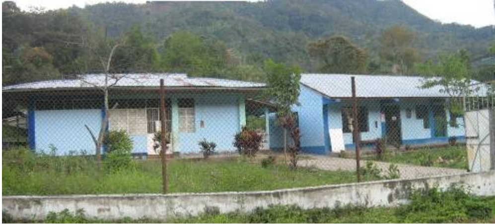
Foto N° 14: Puesto de Salud del Centro Poblado rural Naranjal.
