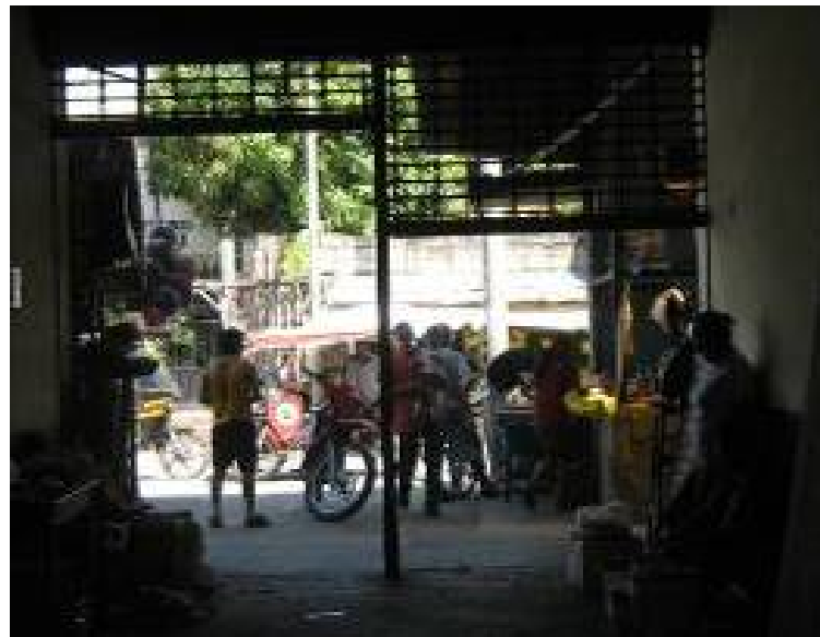
Foto N° 71: Obstrucción de salida de evacuación en Mercado Modelo
