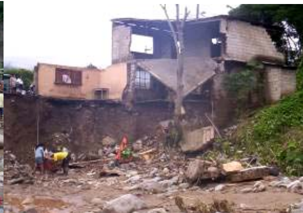
Fotos N° 75 y 76 : Inmuebles colapsados y afectados por flujos de lodo y detritos
