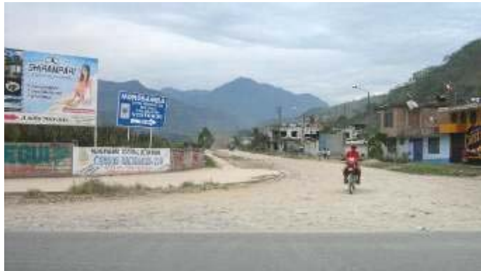
Foto N° 41 : Carretera a Vítoc y Monobamba
