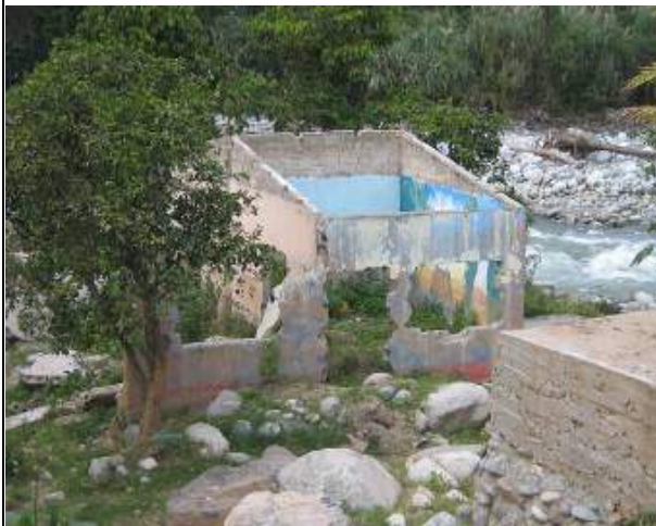
A.H. Malecón Tarma afectado por erosión fluvial del río Tarma y flujo de lodo y detritos de la Qda. Huacará. 22/01/2007
