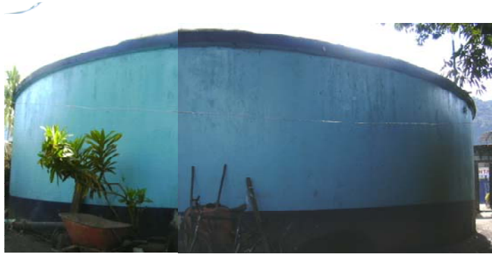
Foto N° 24 : Vista reservorio 600 m3
