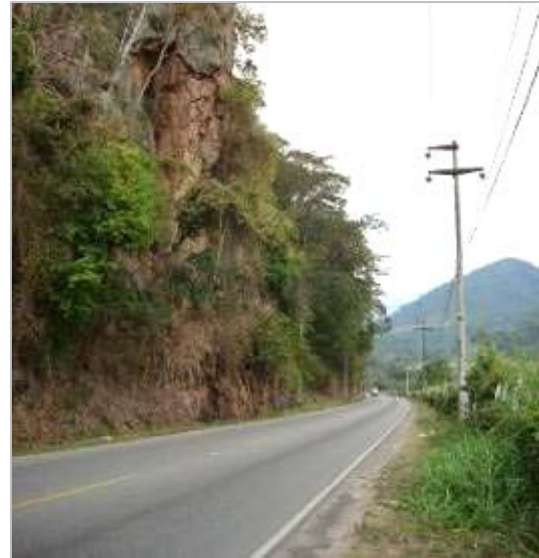
Foto N° 37 : Carretera Central tramo La Merced – San Ramón
