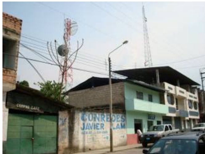
Foto Nº 60 : Antenas de telecomunicaciones en la ciudad de San Ramón
