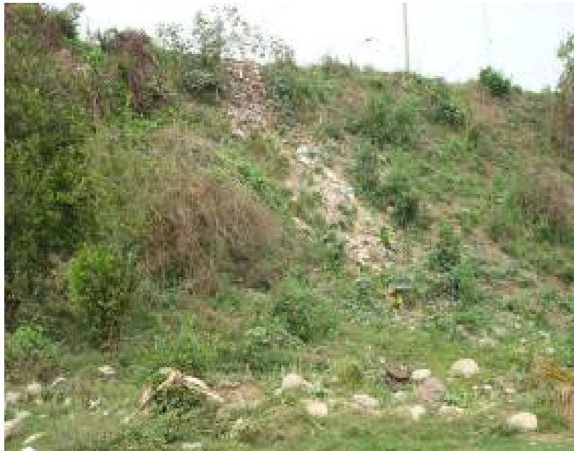
Foto N° 57 : Botadero de residuos sólidos en el área urbana, antigua quebrada Apulimac
