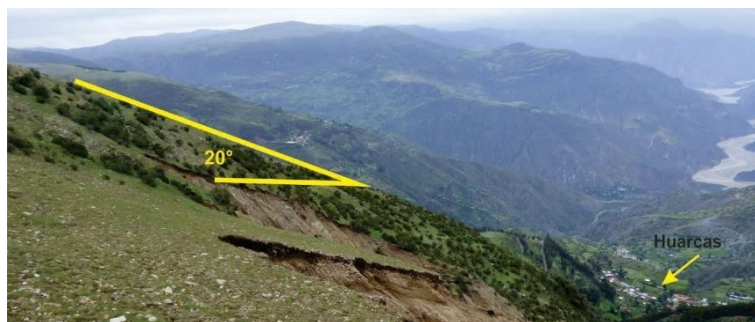
Foto 1. Parte de la quebrada Huarcas, donde las laderas presentan una pendiente de 20^\circ .
