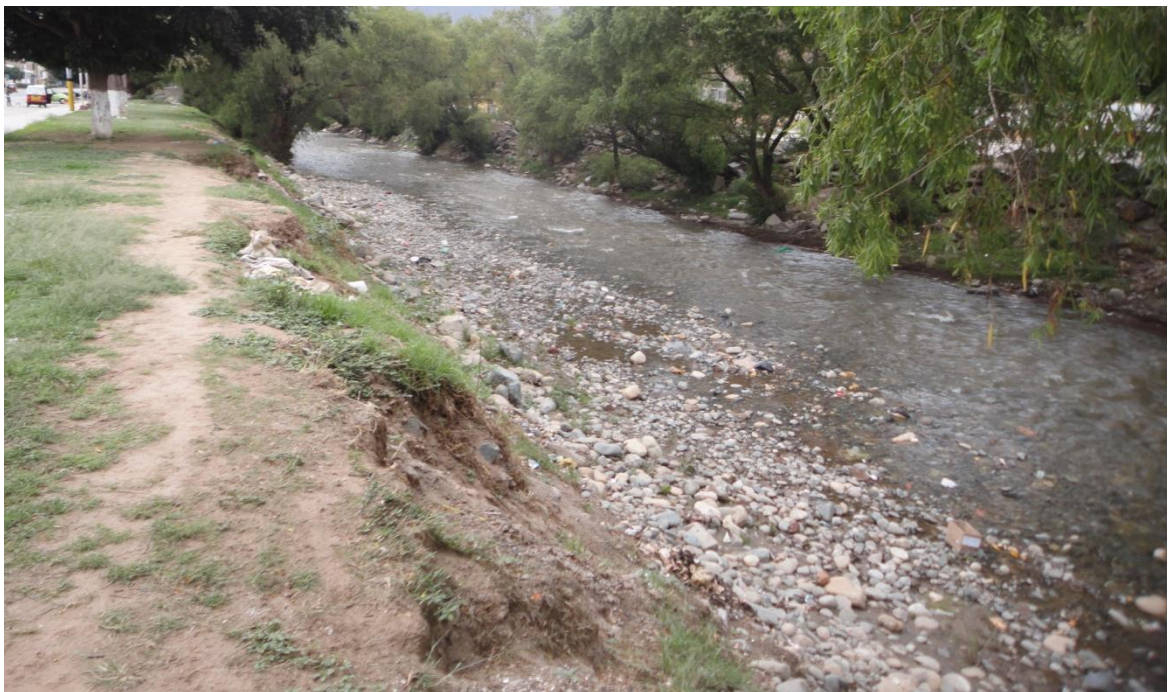
Foto 1.- Cauze del río Higuera, se muestra de forma rectilínea
