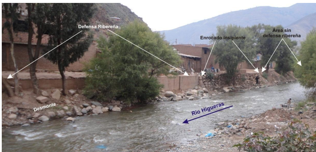
Foto 8.- Se observa defensas ribereñas y zonas que carecen de ellas.
