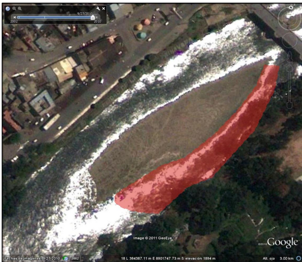
Figura 13.- Canal colmatado del río Huallaga.
