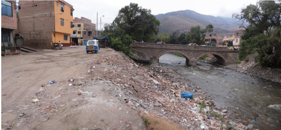
Foto 11.- Puente sobre el río Higueras, se aprecia en su margen desmonte y basura. También se observa su cauce colmatado.
