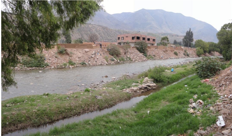
Fotos 5, 6 y 7.- Margen derecha del río Higueras con desmonte y basura.
