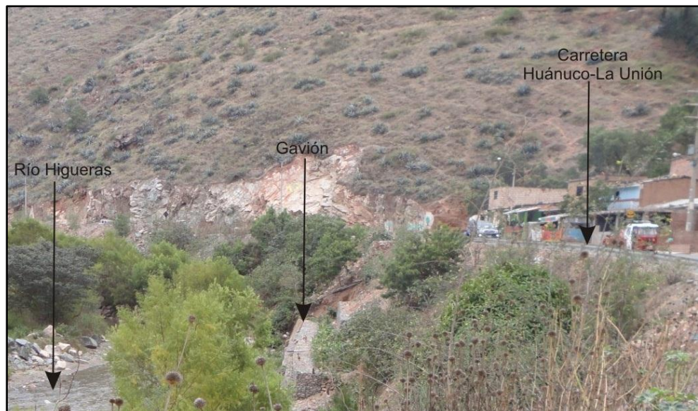
Foto 4.- Sector Cabrito Pampa, en la margen derecha se muestran gaviones.
