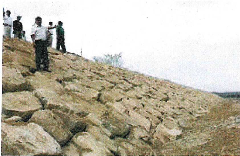
Imagen N° 06: Protección con geobolsas
