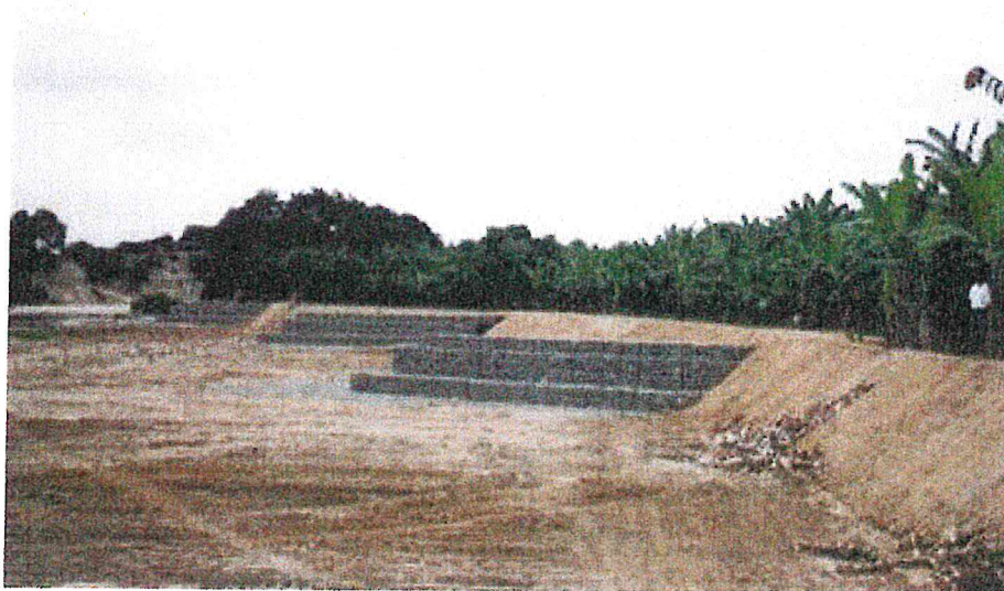
Imagen N° 10: Protección con espigones de gaviones
