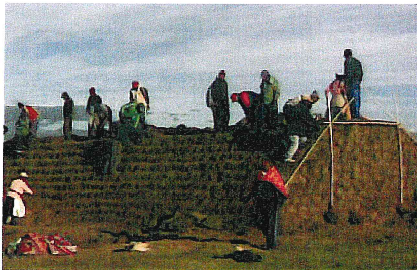
Imagen N° 14: Dique de bloques vegetativo
