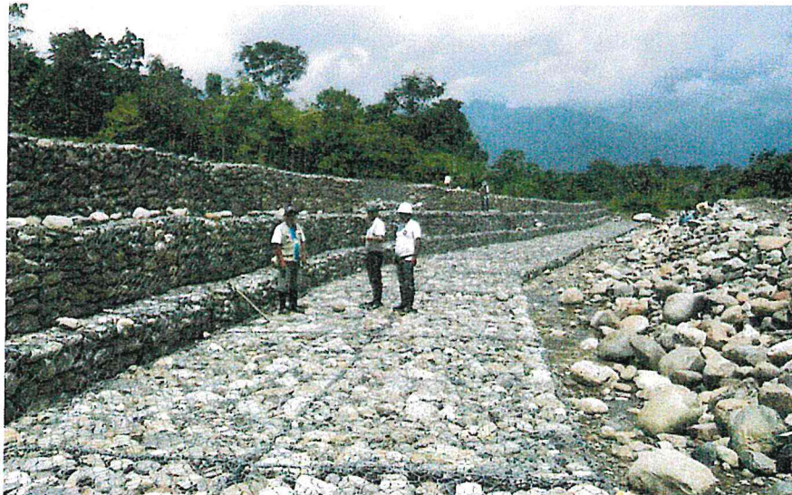
Imagen N° 08: Protección con gaviones
