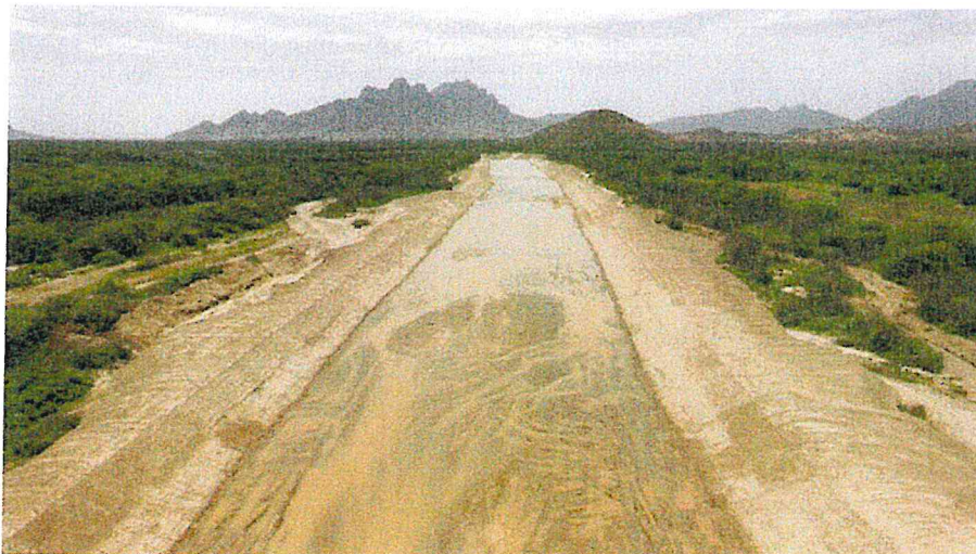
Imagen N° 16: Extracción de material sedimentado de cauce
