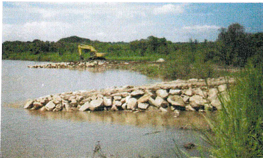
Imagen N° 11: Protección con mampostería de piedra
