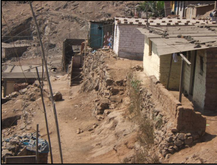
Foto 4.- Pirca con altura de 2,00 m, sector de la manzana "K".
