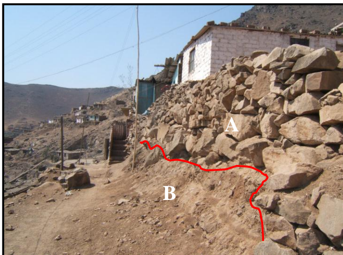
Foto 3.- Vivienda de la manzana “K”, se muestra una pirca (A) con altura hasta de 1,70 m, compuesta en gran parte por bloques. En la parte inferior se aprecia suelo (B).
