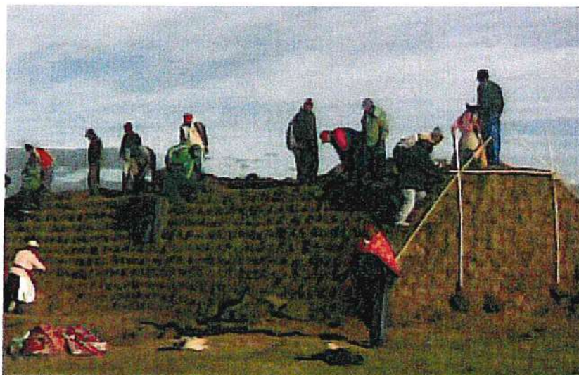
Imagen N° 14: Dique de bloques vegetativo
