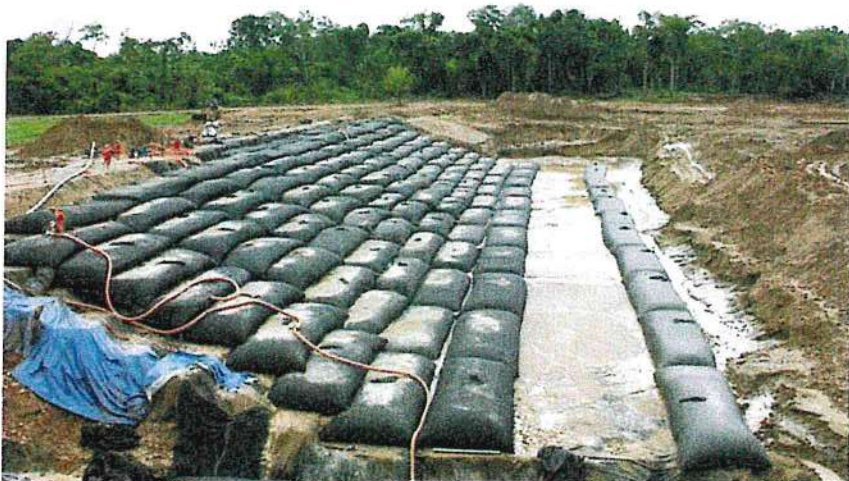
Imagen N° 06: Protección con geobolsas
