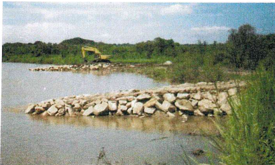
Imagen N° 11: Protección con mampostería de piedra
