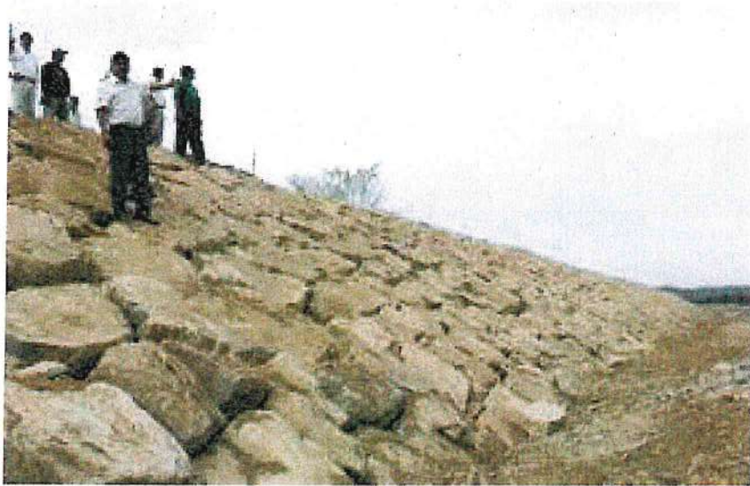
Imagen N° 06: Protección con geobolsas
