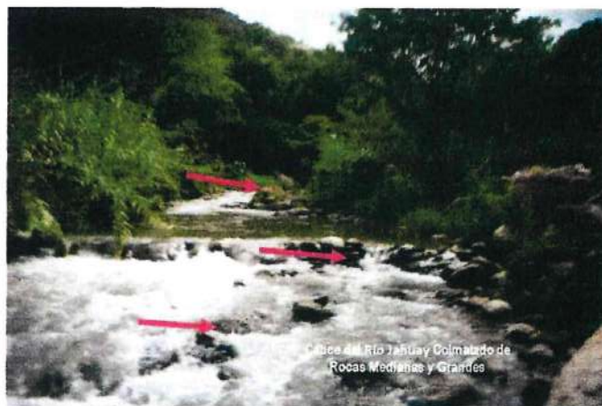
FOTO 3. TRAMO DEL RÍO JAHUAY COLMATADO DE ROCAS MEDIANAS Y GRANDES.
