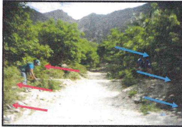
FOTO 1. QDA. HORNOPAMPA IDENTIFICADA COMO ZONA CRITICA, EN LA IMAGEN SE NOTA CLARAMENTE LA COLMATACION Y EL DEBILITAMIENTO DE LOS TALUDES EN DONDE ES NECESARIO INTERVENIR.
