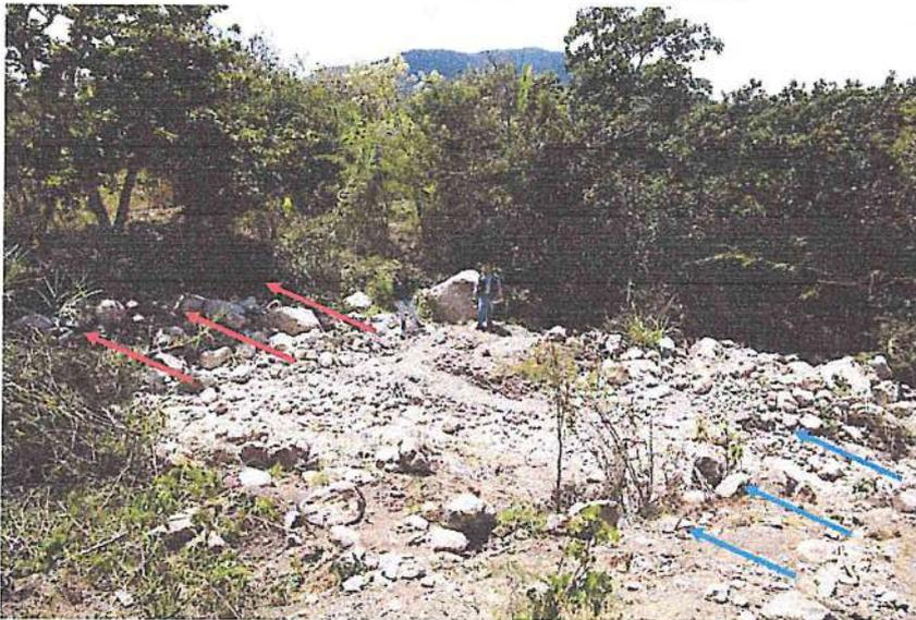
FOTO 2. ZONA BAJA DE LA QDA. SAN ISIDRO, EN LA IMAGEN SE EVIDENCIA LA COLMATACION Y EL DEBILITAMIENTO DE TALUDES EN AMABAS MARGENES DE LA QUEBRADA.
