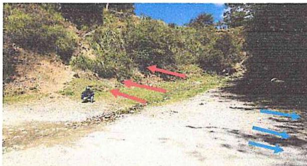
FOTO 1. QDA. CHAQUIL IDENTIFICADA COMO ZONA CRITICA, EN LA IMAGEN SE NOTA CLARAMENTE LA COLMATACION Y EL DEBILITAMIENTO DE LOS TALUDES EN DONDE ES NECESARIO INTERVENIR.
