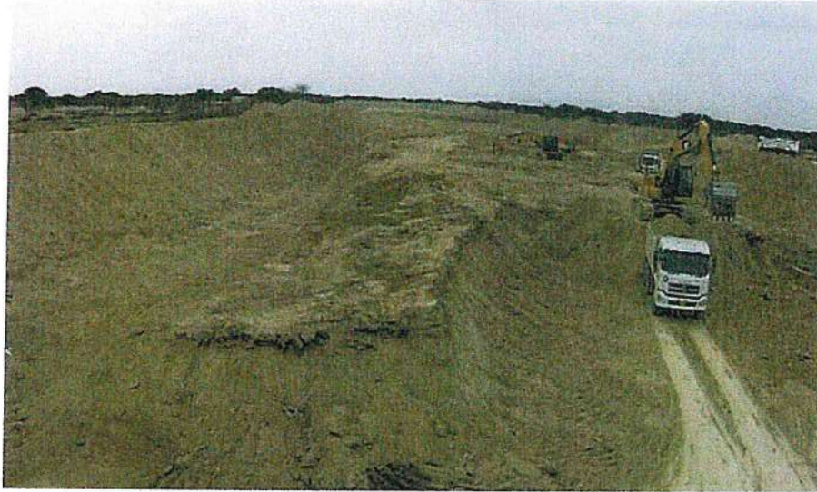
Imagen N° 16: Extracción de material sedimentado de cauce
