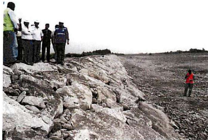
Imagen N° 04: Defensa ribereña (dique enrocado)
