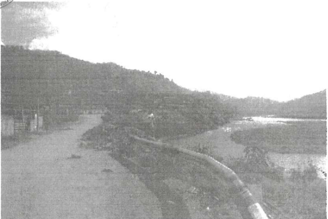
Vista Fotográfica de márgenes de río en riesgo a erosión
