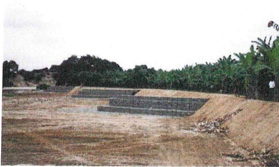
Imagen N° 10: Protección con espigones de gaviones
