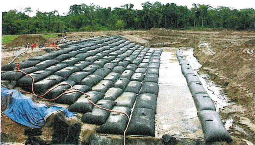
Imagen N° 06: Protección con geobolsas
