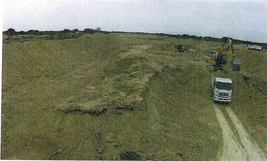
Imagen N° 16: Extracción de material sedimentado de cauce
