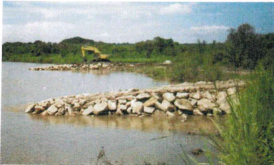
Imagen N° 11: Protección con mampostería de piedra
