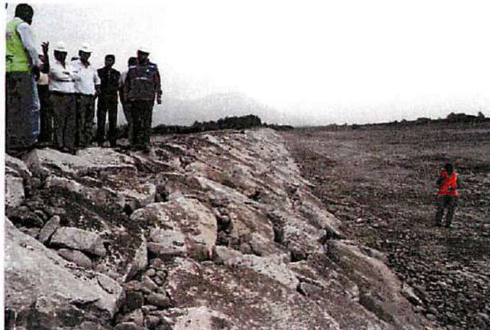
Imagen N° 01: Defensa ribereña (dique enrocado)
