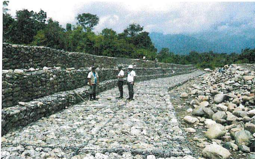
Imagen N° 08: Protección con gaviones
