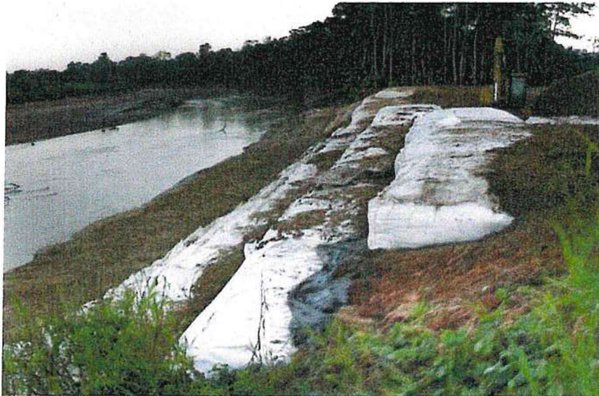
Imagen N° 07: Protección con geobolsas
