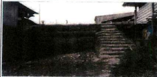
Defensa ribereña presente en el sector ubicada en el sector de la calle Putumayo ultima cuadra.
