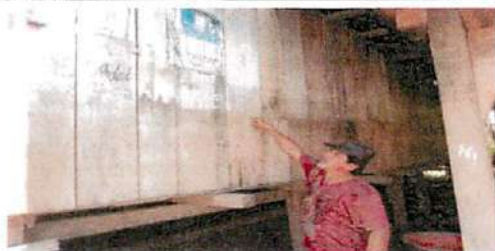
HUELLA DEL NIVEL DE LA CRECIENTE EN EL SECTOR DEL PROYECTO
