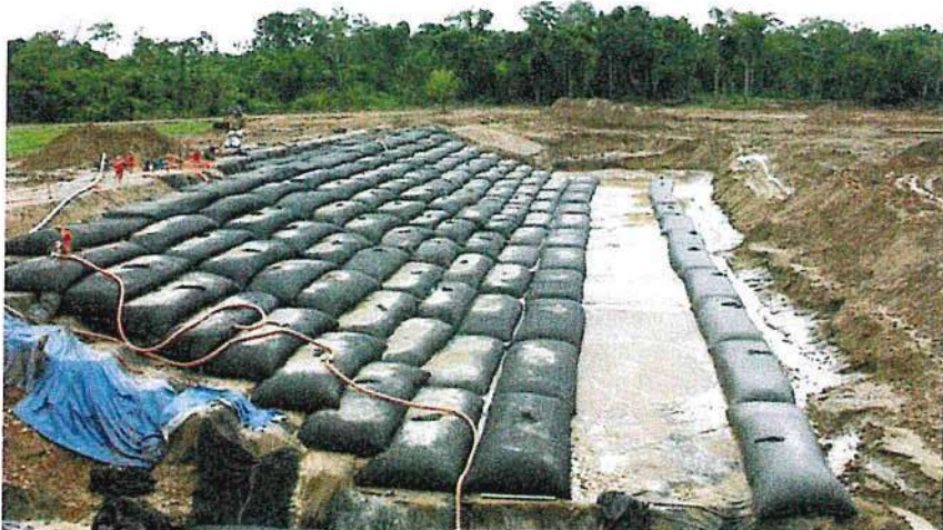
Imagen N° 06: Protección con geobolsas
