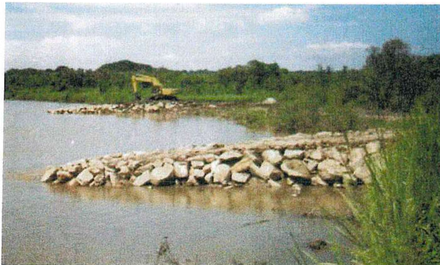
Imagen N° 11: Protección con mampostería de piedra
