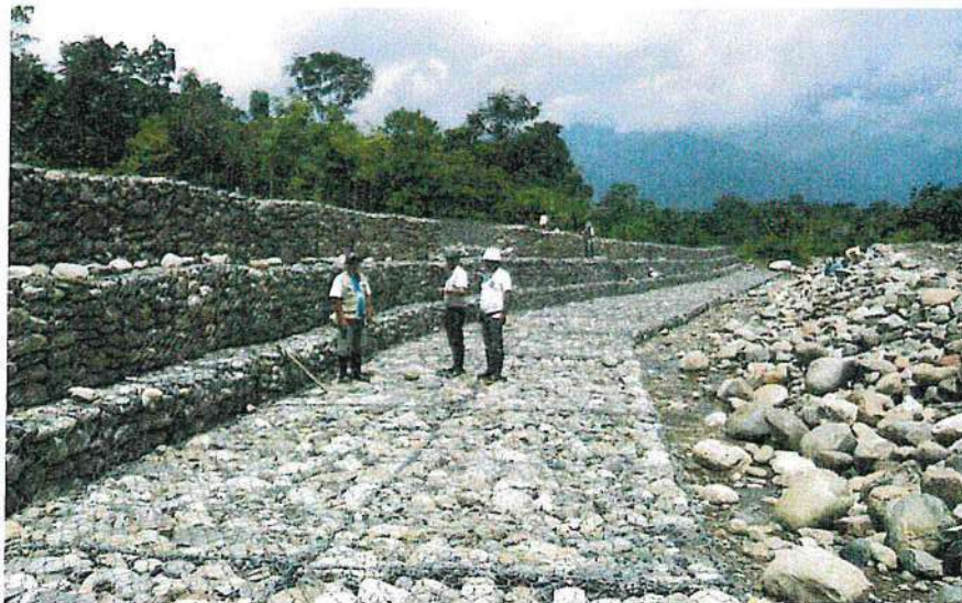
Imagen N° 08: Protección con gaviones
