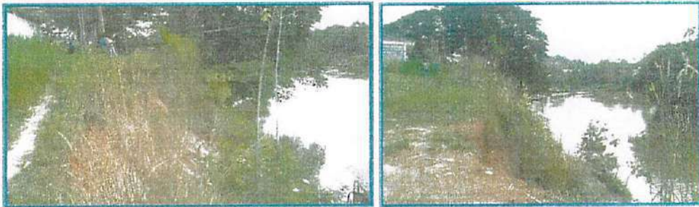
Vistas de la erosión presente en el sector de estudio, la cual abarca aproximadamente 30 metros, perjudicando a la IASS - Cahuide y a una vivienda.
