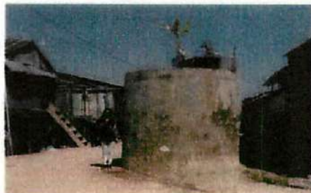
Obra abandonada de barro de defensa cuya altura indica el
