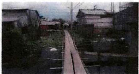
Sector del proyecto inundado en época de creciente
