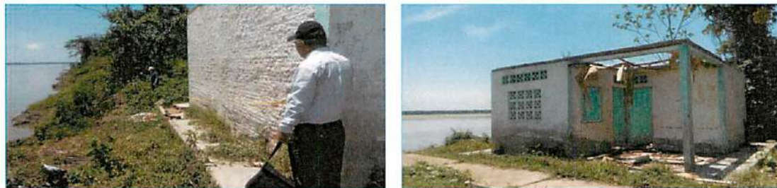
Personal de la ALA-IQUITOS y de la Municipalidad de Belén realizando mediciones a las áreas afectadas por la erosión y vivienda desalojada por estar en la zona de riesgo
