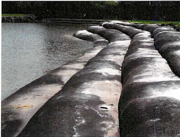
Figura N°05: Muros con bolsacreto
