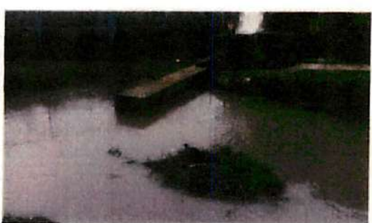
desagues presentes en el sector los cuales incrementan el deterioro ambiental y amenazan la salud de la población
