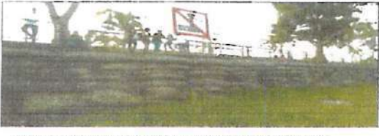
Imágenes de defensa ribereña realizada con Bolsacreto en la ribera del río Amazonas en el puerto de la ciudad de Leticia - Colombia, el cual es capaz de registrar la dinámica del río Amazonas, por lo tanto es una buena experiencia a replicar en la zona del proyecto, con siderando una altura de 4 metros.
