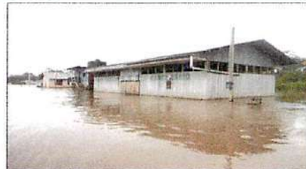
Planta de Agua de la Localidad de Santa Gallo, la cual no está adaptada para las épocas de creciente, por lo tanto paraliza sus funciones durante 6 meses al año.
