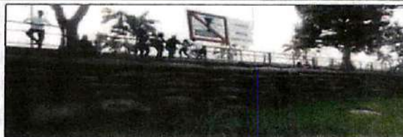
Imágenes de defensa ribereña realizada con Bolsacreto en la ribera del río Amazonas en el puerto de la ciudad de Leticia - Colombia, el cual es capaz de resistir la dinámica del río Amazonas, por lo tanto es una buena experiencia a replicar en la zona del proyecto, considerando una altura de 4 metros.
