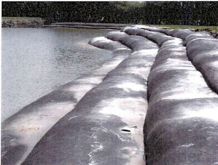
Figura N°05: Muros con bolsacreto
