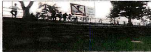
Imágenes de defensa ribereña realizada con Bolsacreto en la ribera del río Amazonas en el puerto de la ciudad de Leticia - Colombia, el cual es capaz de registrar la dinámica del río Amazonas, por lo tanto es una buena experiencia a replicar en la zona del proyecto, con siderando una altura de 4 metros.
