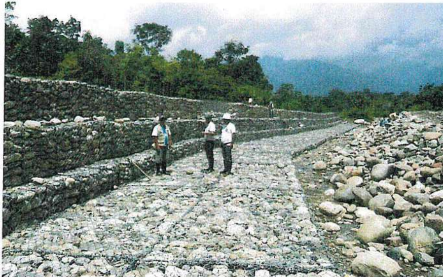
Imagen N° 08: Protección con gaviones
