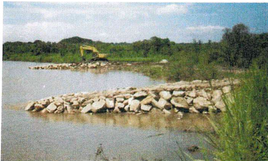
Imagen N° 11: Protección con mampostería de piedra
