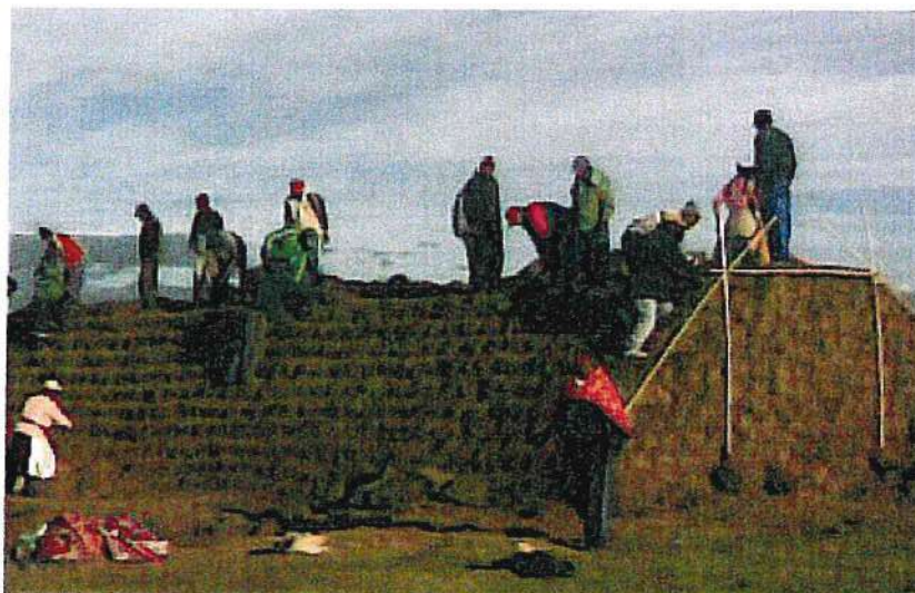
Imagen N° 14: Dique de bloques vegetativo
