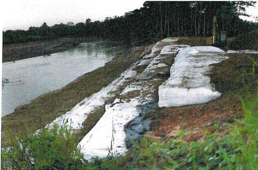
Imagen N° 07: Protección con geobolsas
