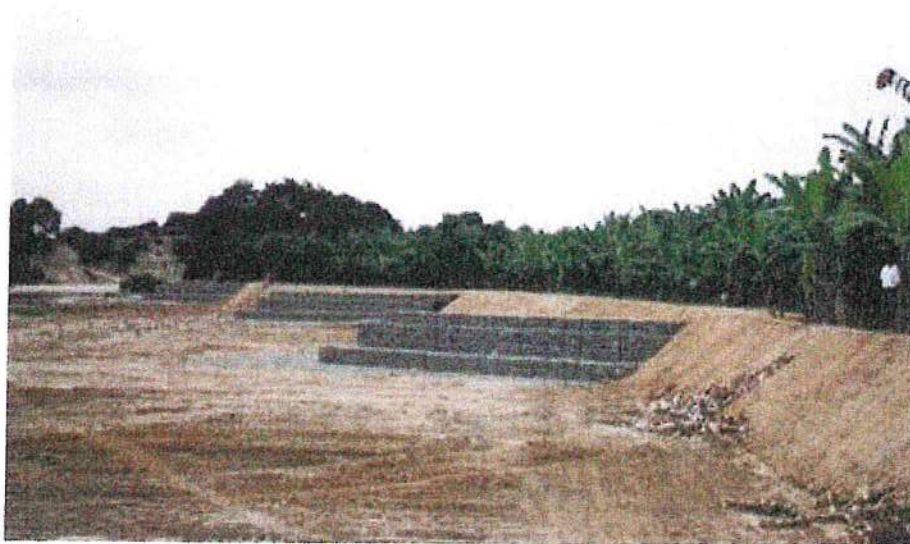
Imagen N° 10: Protección con espigones de gaviones
