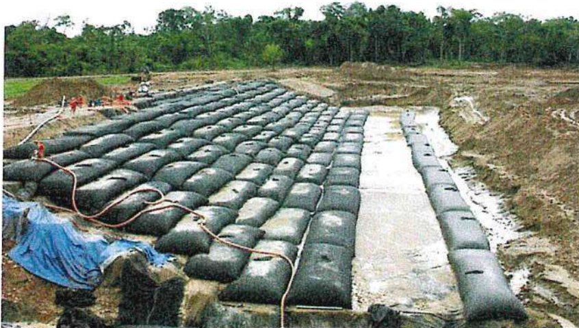
Imagen N° 06: Protección con geobolsas
