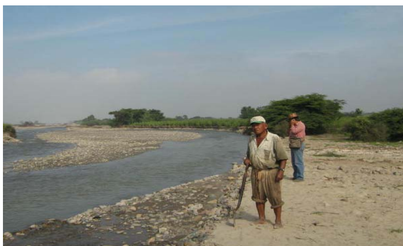
Foto 3.4. Socavación lateral y vertical generada por un ramal del río Matagente, arrasando áreas cultivadas de algodón. Las riberas no tenían defensas.
