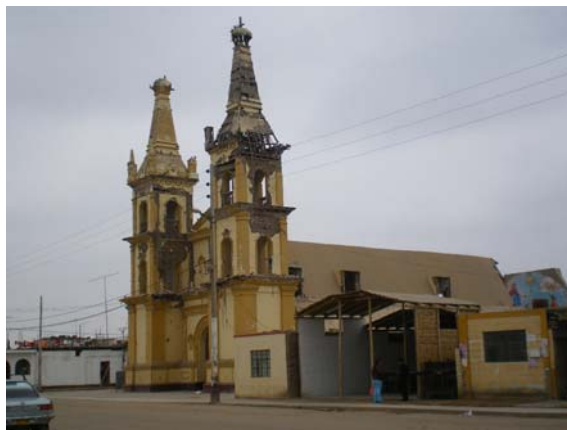
Foto 1.15. Iglesia de adobe+ quincha dañada
