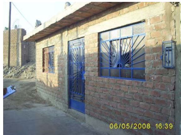
Foto 1.23. Albañilería confinada y solera
