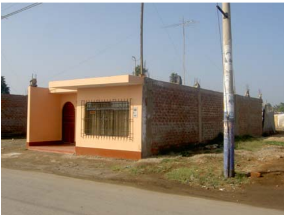
Foto 1.11. Viviendas sin daño
