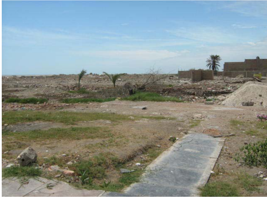
Foto 3.2. Tambo de Mora, planicie de la costa del cuaternario reciente marino (holoceno), zona crítica por licuación de arenas que destruyó la ciudad en el sismo de 15 de Agosto del 2007.
