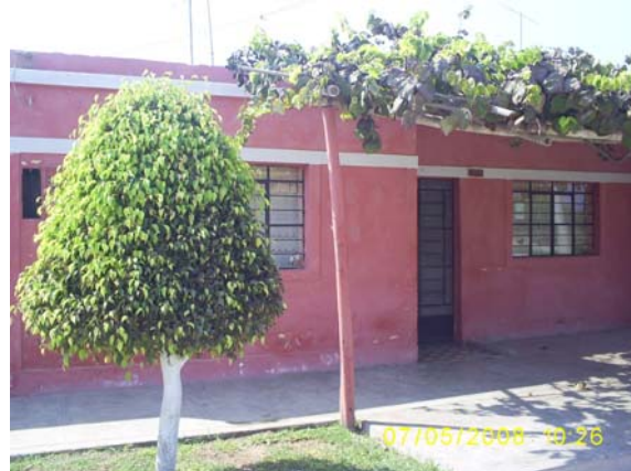
Fotos 1.24. Viviendas de albañilería confinada sin daño en la Urb. Juan XXIII
