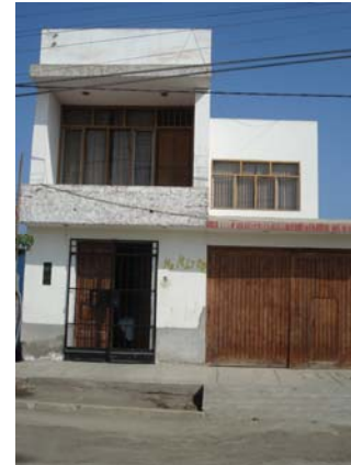
Foto 1.12. Viviendas sin daño
