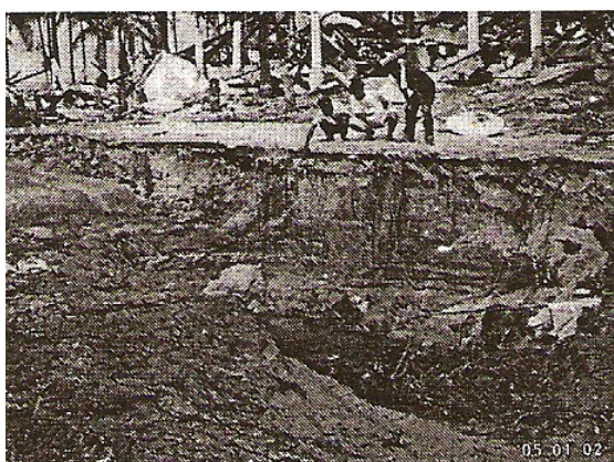
Foto 2.5. Erosión en Indonesia. Sismo del 26/12/2004.
