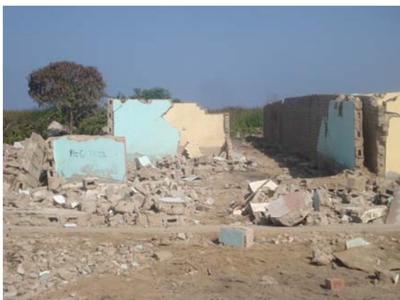
Foto 1.1: Volteo en muro de adobe
