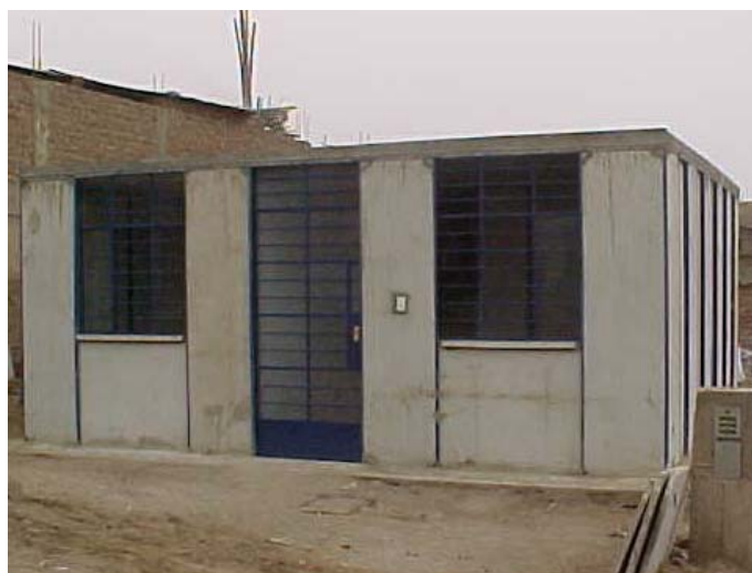
Foto 5.5. Prototipo CS construido en AA.HH. Pacifico II
