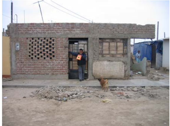
Foto 1.21. Albañilería confinada y solera
