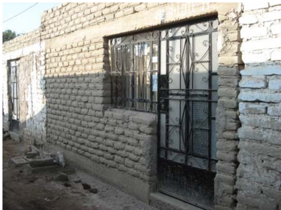
Foto 1.20. Vivienda de Adobe con solera
