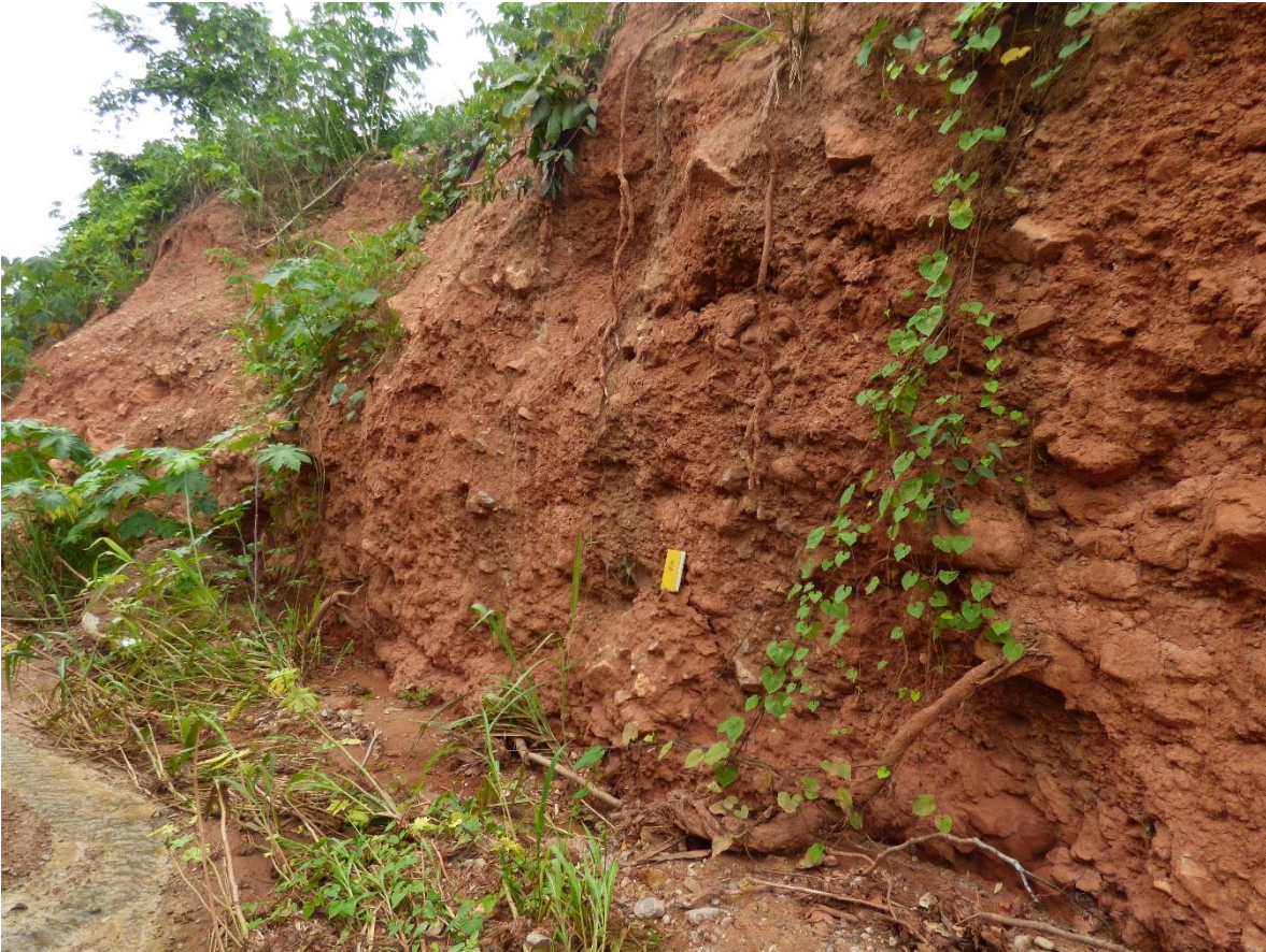
Foto 5: Margen derecha de la quebrada Canaán Edén, se muestra un depósito dejado por huaico, muestra los tamaños de los bloques de roca, dispuestos en forma caótica.
