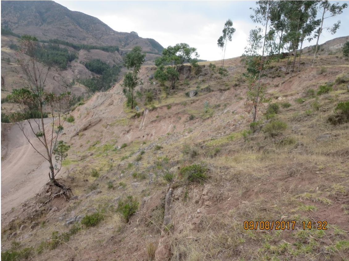
Fotografía 10. Vista con dirección noroeste, se observa el evento reactivado, que afecta tramo de vía y terrenos de pastoreo.
