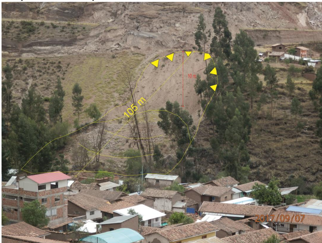
Fotografía 7. Vista del evento (D-4), ubicado a la margen izquierda del río Paruro, talud inferior de la vía Yaurisque – Paruro, se observa el deslizamiento ocurrido el año 2017.
