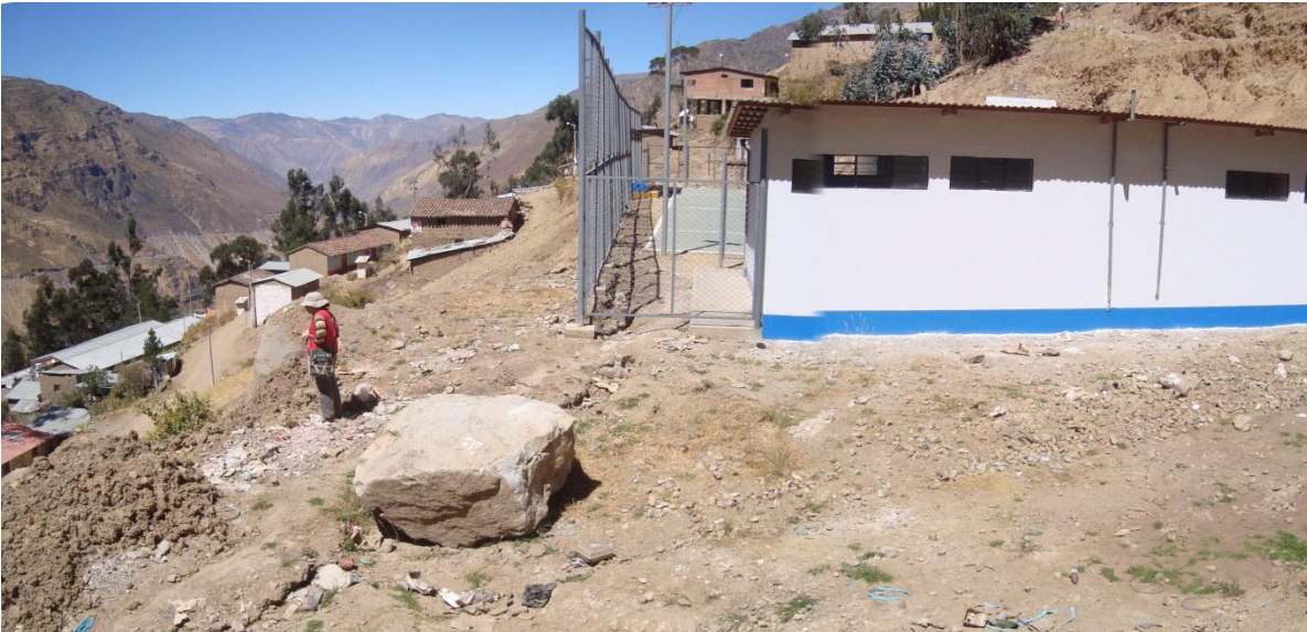
Foto 10. Vista de bloques de roca producto de la caída que llegaron hasta las inmediaciones de loza deportiva.
