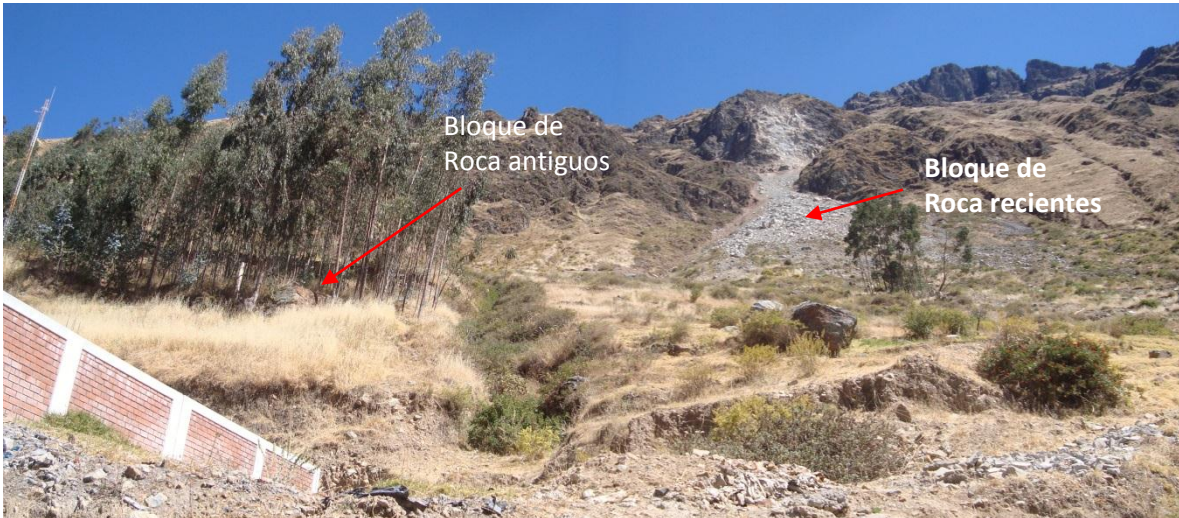
Foto 9. Bloques de roca sobre el colegio Jose María Arguedas correspondiente a caídas de rocas antiguas.
