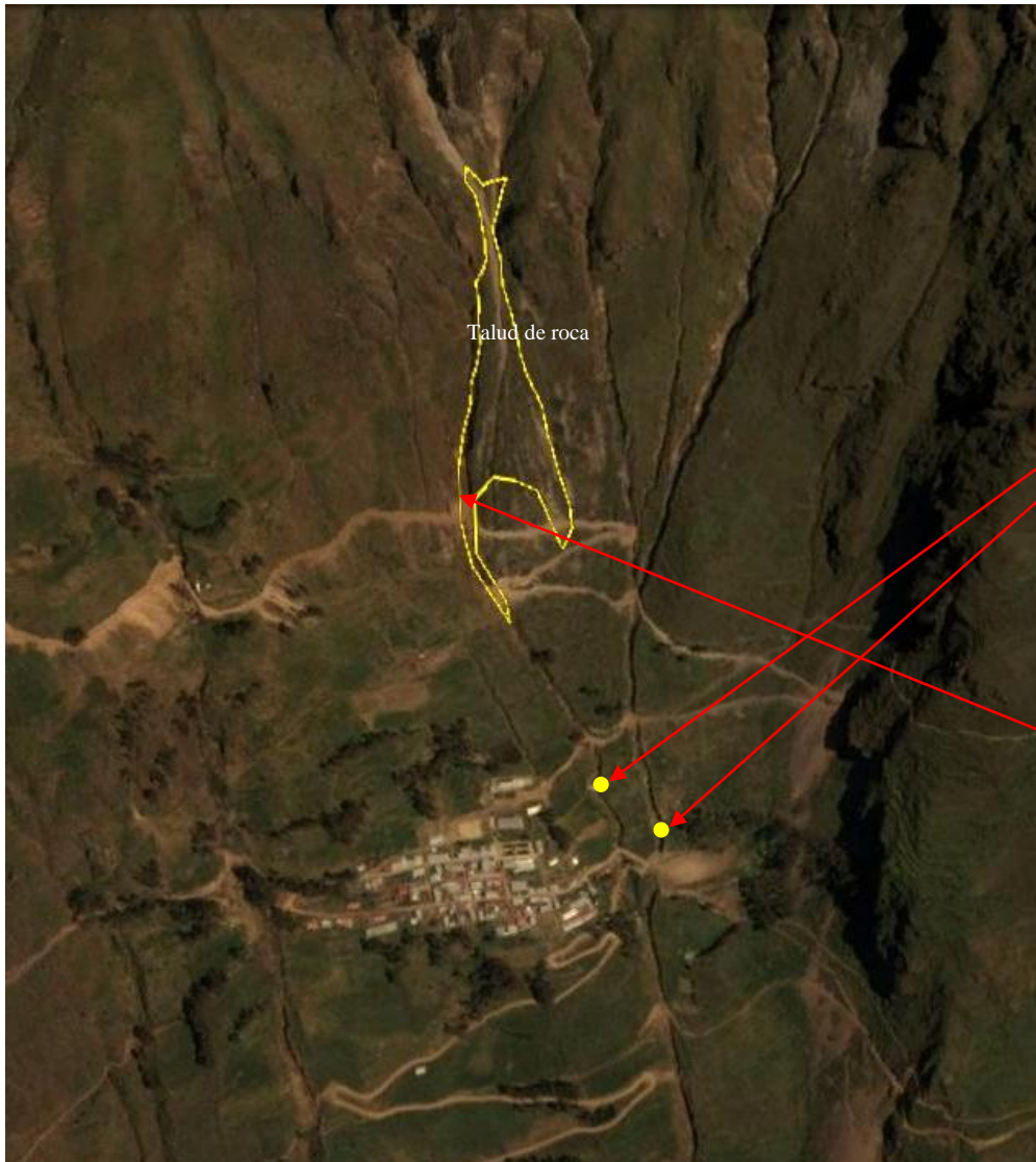
Figura 5. Talud de rocas y bloques producto del desprendimiento de rocas del cerro Huamatambo – sector Virgen Ccacca
