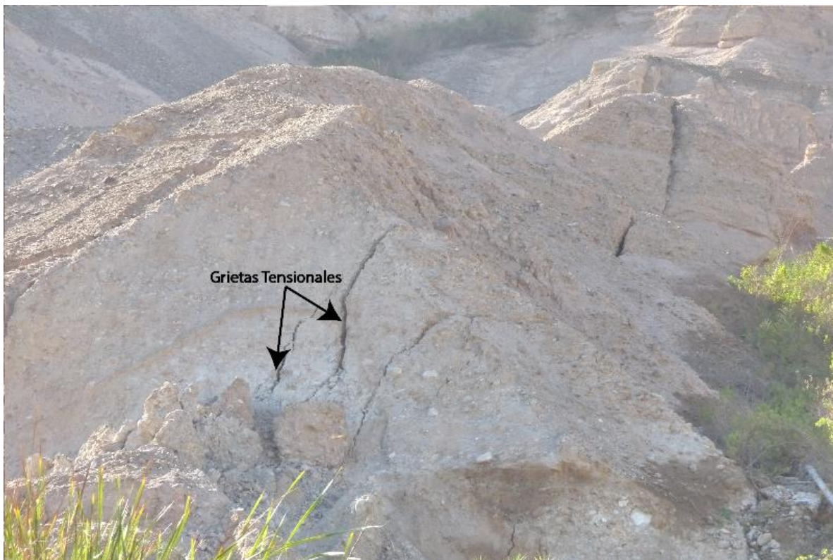
Fotografía 5: Grietas tensionales en la masa desplazada del cuerpo del deslizamiento.
