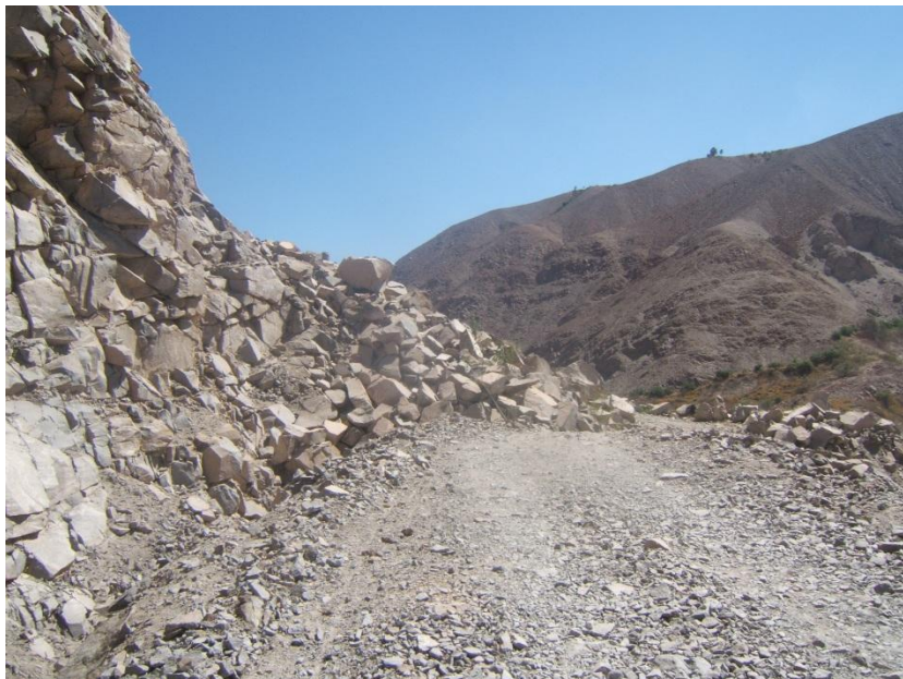
Fotografía 1: Derrumbes en el río Vítor (margen izquierda) interrumpiendo camino rural
