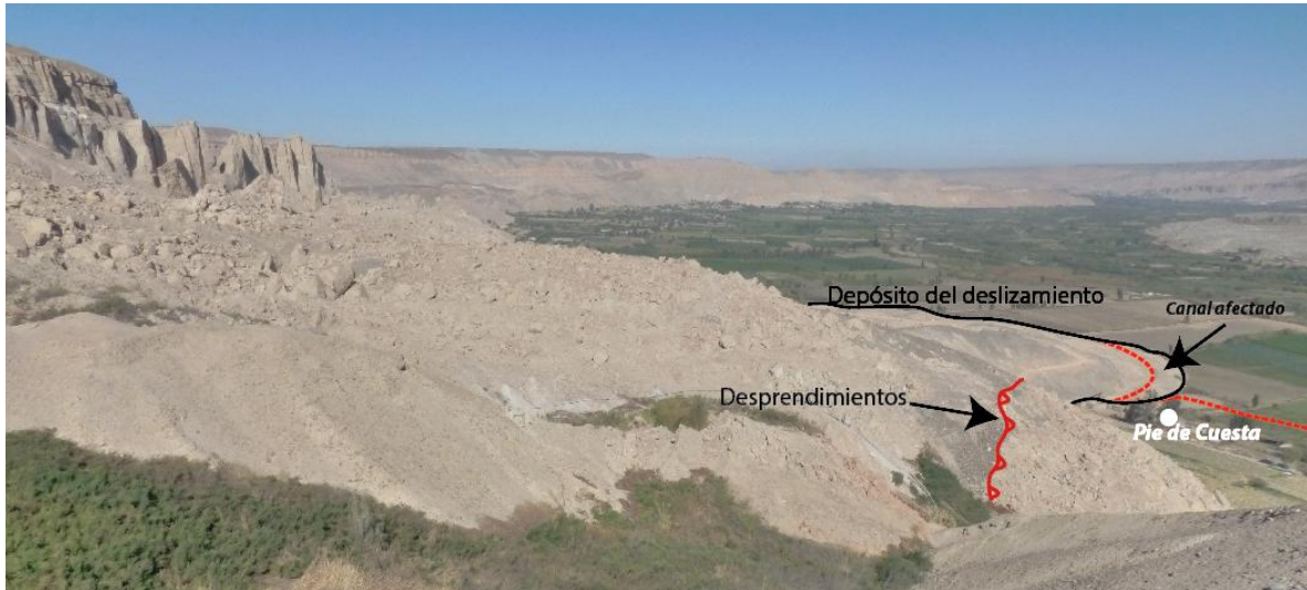
Fotografía 4. Vista de las parcelas agrícolas del poblado Pie de Cuesta y del canal de irrigación (líneas rojas entrecortadas) afectados por el depósito del deslizamiento activo, . Se observa también desprendimiento de bloques de arenisca tobáceas y conglomerados.
