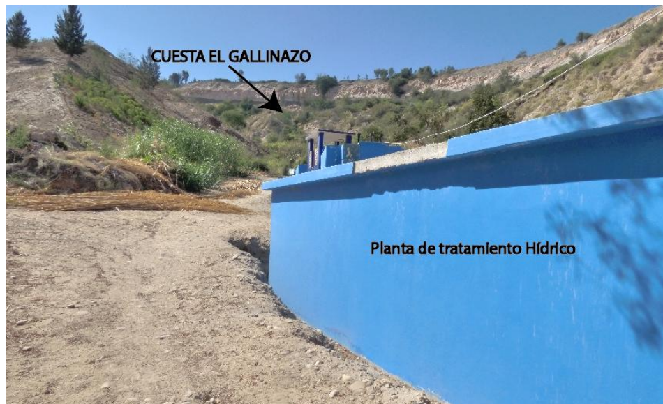
Fotografía 10: Planta de Tratamiento ubicada en el pie de la Cuesta I Gallinazo
