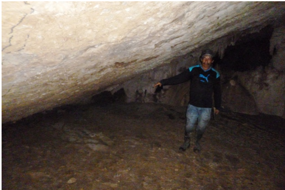
Foto N° 45: Inclinación de los estratos de caliza que favorece al desprendimiento de bloques, en el interior de la caverna, estos estratos tienen una inclinación de 35^\circ en la dirección EO.
