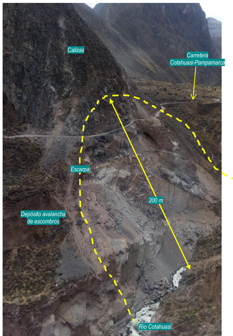
Figura 7. Derrumbe del 14 de marzo 2017 que afectó el cerro Chipito. La zona de arranque posee una extensión inclinada de casi 200 m y llegó hasta el río Cotahuasi. El derrumbe afectó a las calizas de la Formación Alcurquina y depósitos de avalanchas de escombros. Fotografía en dirección NNE.
