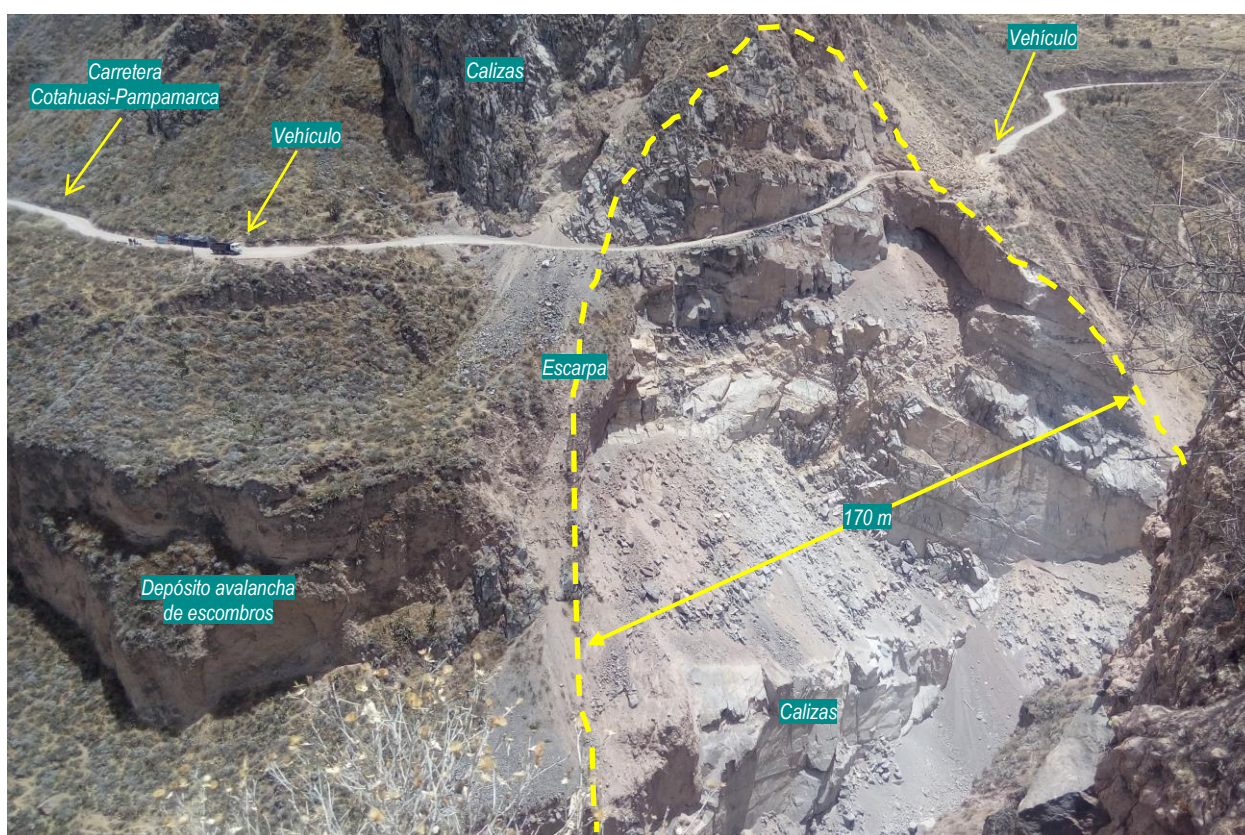
Figura 8. Derrumbe del 14 de marzo 2017, que afectó un tramo de casi 150 m de la carretera Cotahuasi-Pampamarca. Se puede observar que las calizas de la Formación Alcurquina buzcan en forma favorable a la pendiente del terreno y se encuentran bastante fracturadas. Los depósitos de avalancha de escombros sobreyacen a las calizas y son depósitos no consolidados. La escarpa del derrumbe posee un ancho máximo de 170 m. Fotografía en dirección NNE.
