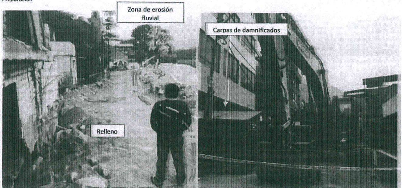
Fotografía 20: Zona erosionada por el río Rímac
