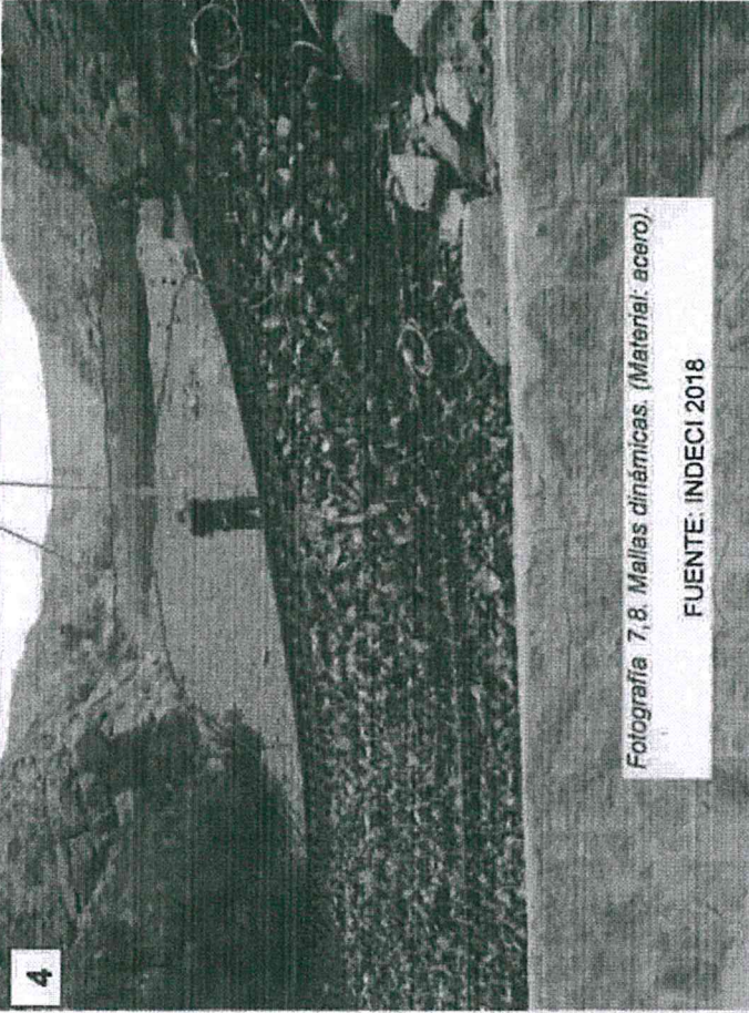
Material rocoso esparcido entre ambas mallas dinámicas
