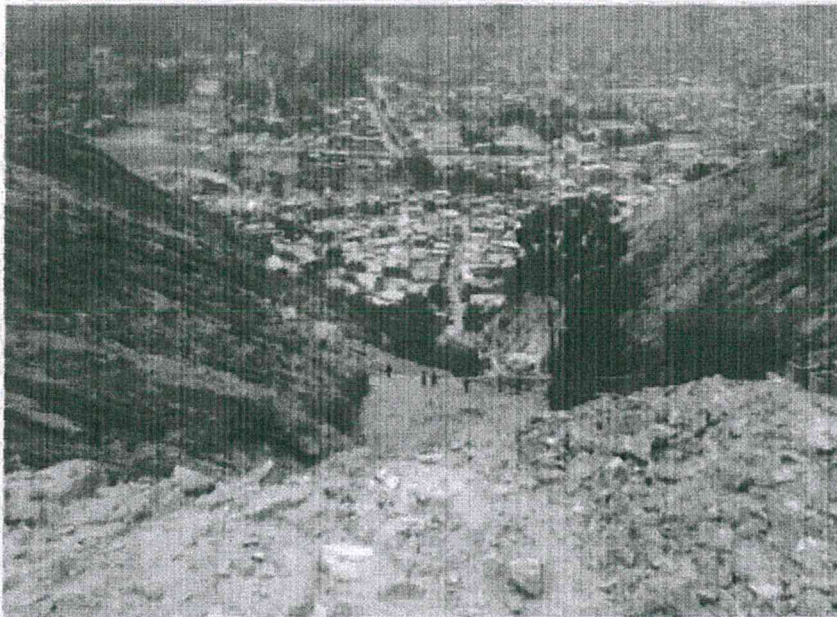
Fotografía 5. Quebrada Carosio colmatada el año 2017 en el "Fenómeno del niño 2017". La quebrada cuenta con 3 mallas dinámicas, 2 de ellas colmatadas al 100% y 1 al 20%.
