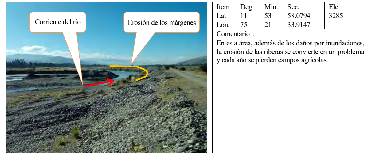
Figura 6.3.18 Estado de Mito, río Mantaro
