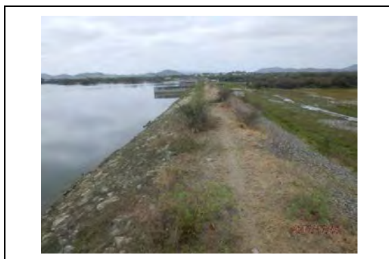
Figura 13.3.52 Aliviadero a ser recrecido del reservorio de Poechos (100mx4 = 400 m)
