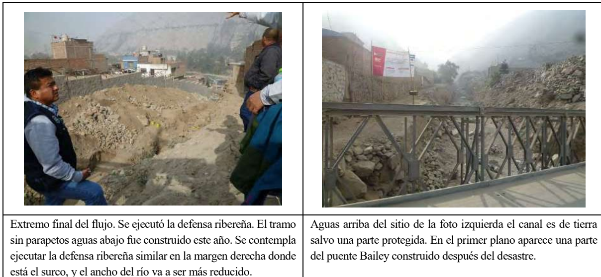
Figura 13.3.88 Condiciones actuales de la quebrada Corrales y
