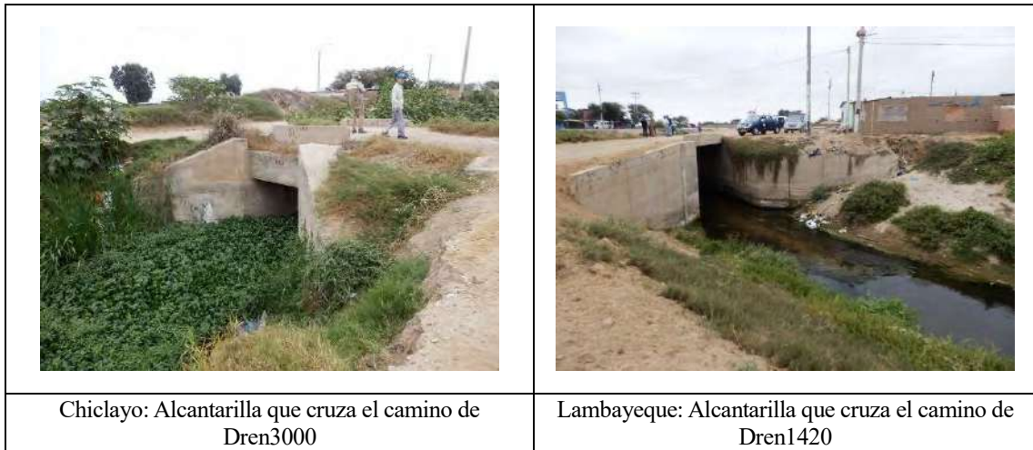
Figura 13.3.64 Obstáculos que cruzan el canal de drenaje existente y la alcantarilla que cruza el camino
