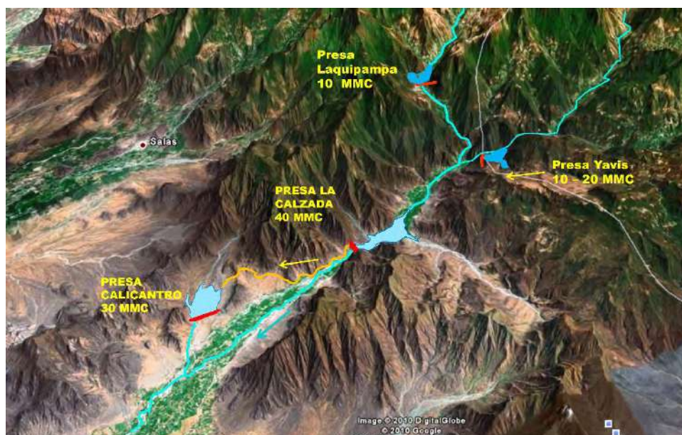
Figura 13.3.58 Plan de construcción de la presa en la cuenca alta del río La Leche de la Oficina del Proyecto Especial de Olmos - Tinajones
