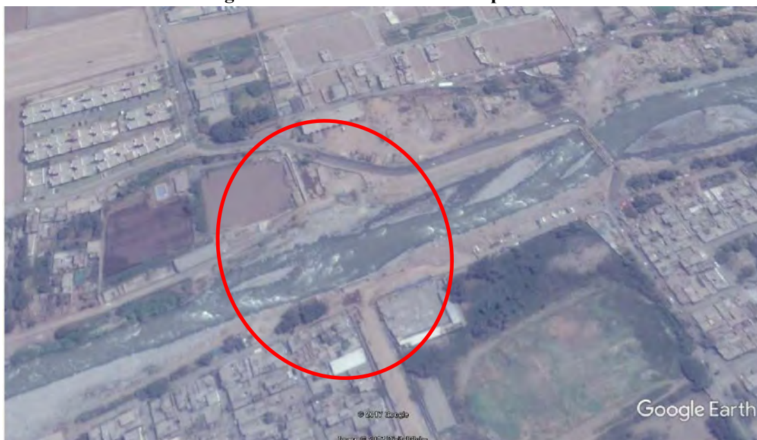
Figura 13.3.103 Foto satelital del puente Ñaña
