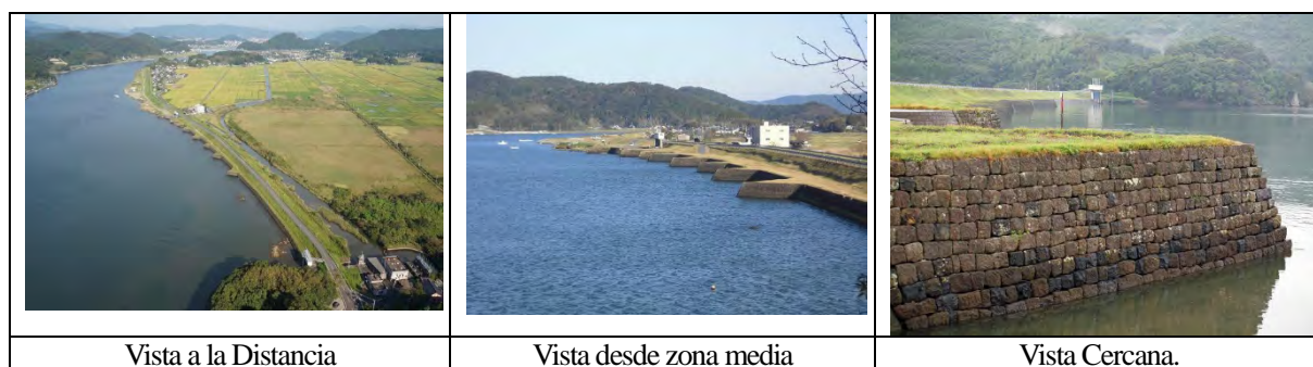
Figura A2.3 Ejemplos reales de Espigones construidos en el Segmento-II los cuales fueron construidos hace mas de 200 años en el Japon (Rio Sendai)
