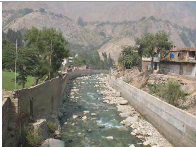
Foto 1: Rimac es uno de los ríos que inunda varios lugares en su curso. Aquí se puede ver paredes de protección a ambos márgenes
