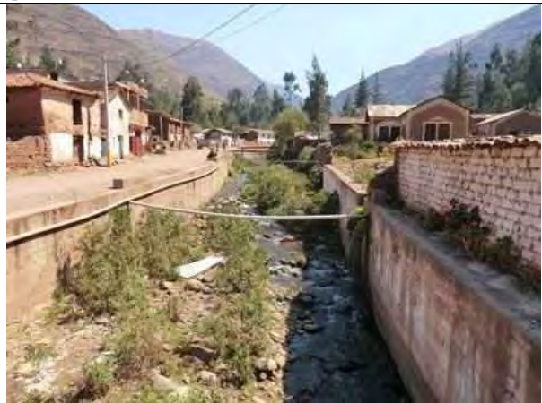
Foto 10: Rio Lucre, tributario del Rio Urubamba-Vilcanota. El canal del rio en su parte alta es más profunda y más ancha. En su parte baja donde sucede la inundación no se puede ensanchar el cauce debido a la oposición de los vecinos a la relocalización.
