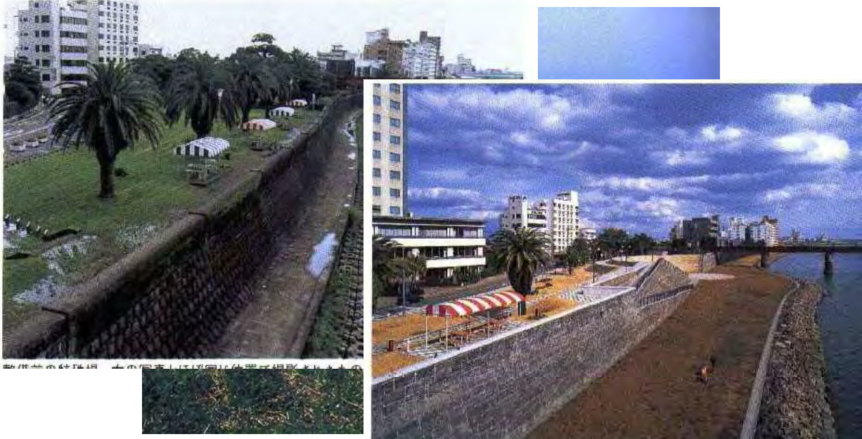
大淀大橋から下流方向を望む。特殊堤とともに、イベント広場を設置した橋公園も新
