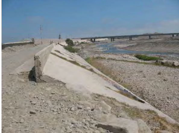
Foto 5: Muro de contención para mitigar la inundación en el Rio Pisco
