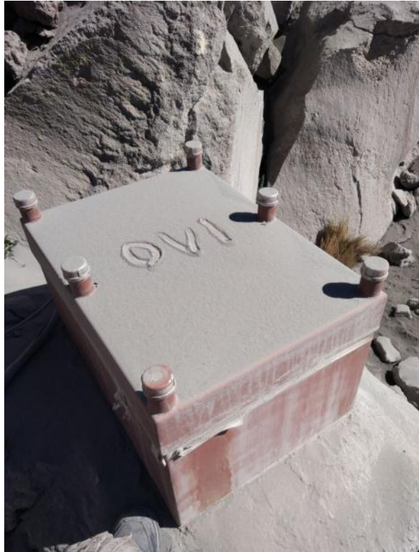
Foto 6: Caseta metálica de una estación de monitoreo del OVI cubierta con ceniza
