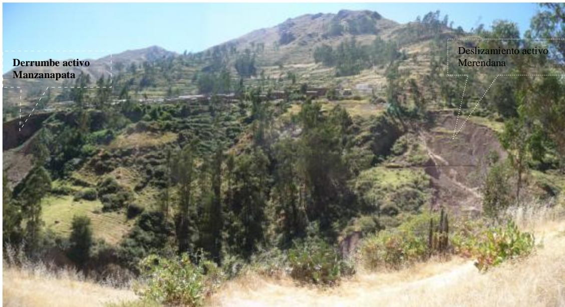
Foto N° 10 Se observa el deslizamiento del año 1944 y las zonas reactivadas como deslizamientos y derrumbes
