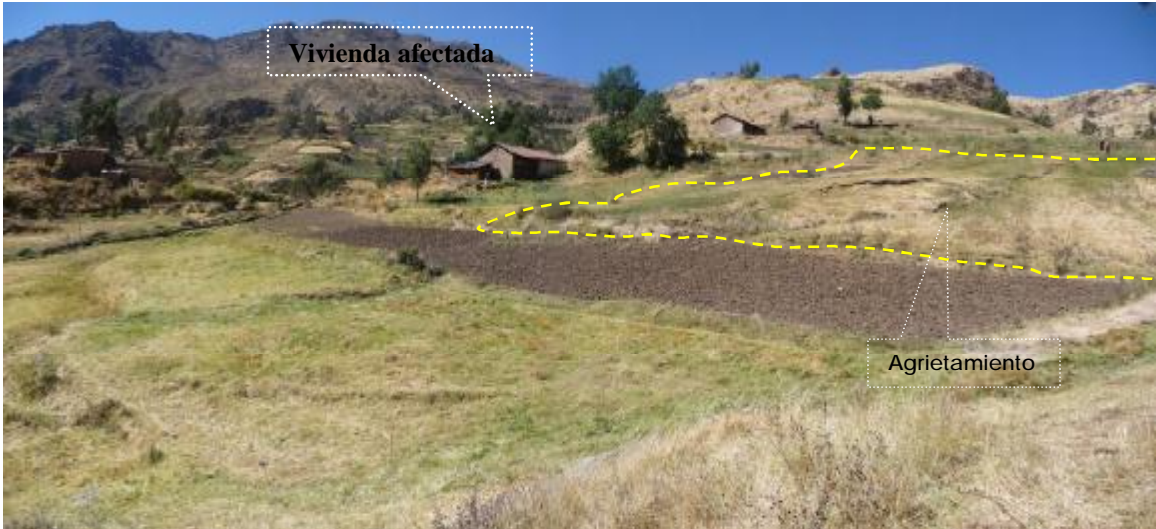
Foto N° 4 Vista panorámica, zona con presencia de agrietamientos, que indica un deslizamiento rotacional lento
