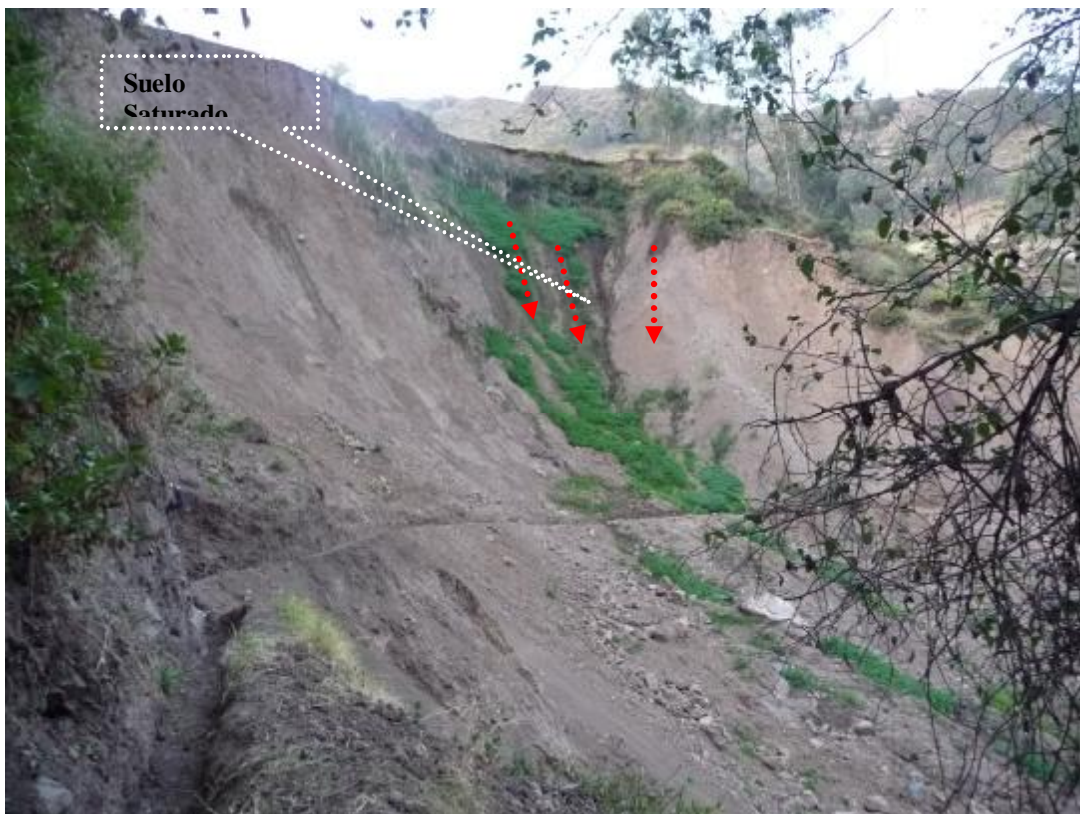
Foto N° 13 Vista panorámica de la zona del Derrumbe en Manzanapata
