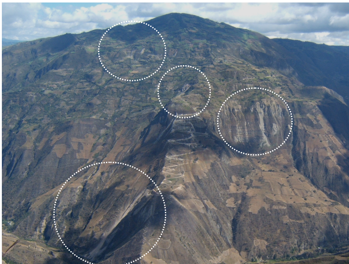
Foto 5. Sector de Rodeopampa (Anguía), margen izquierda del río Conchán. Se aprecia algunas zonas de arranque, derrumbes en algunos cortes de carretera, erosión en cárcavas en la ladera inferior y reactivación en la escarpa de deslizamiento antiguo hacia el valle del río de Súcota.
