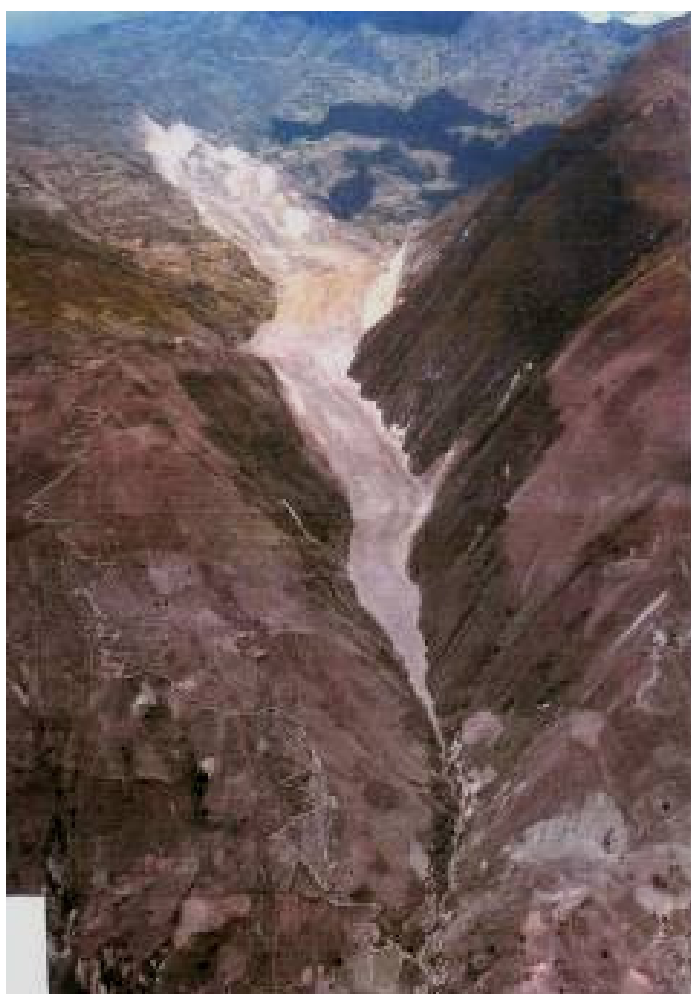
Foto 7. Otras vistas del deslizamiento de La Púcara. Se aprecia la zona de arranque o escarpa de gran dimensión. En la vista inferior el flujo aguas abajo
