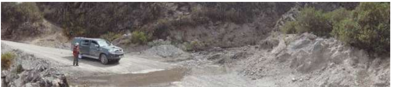
Figura 18: Flujo de detritos (huaicos) en la quebrada Chifon. Movimiento en masa frecuente en la zona. Afecta trocha carrozable
