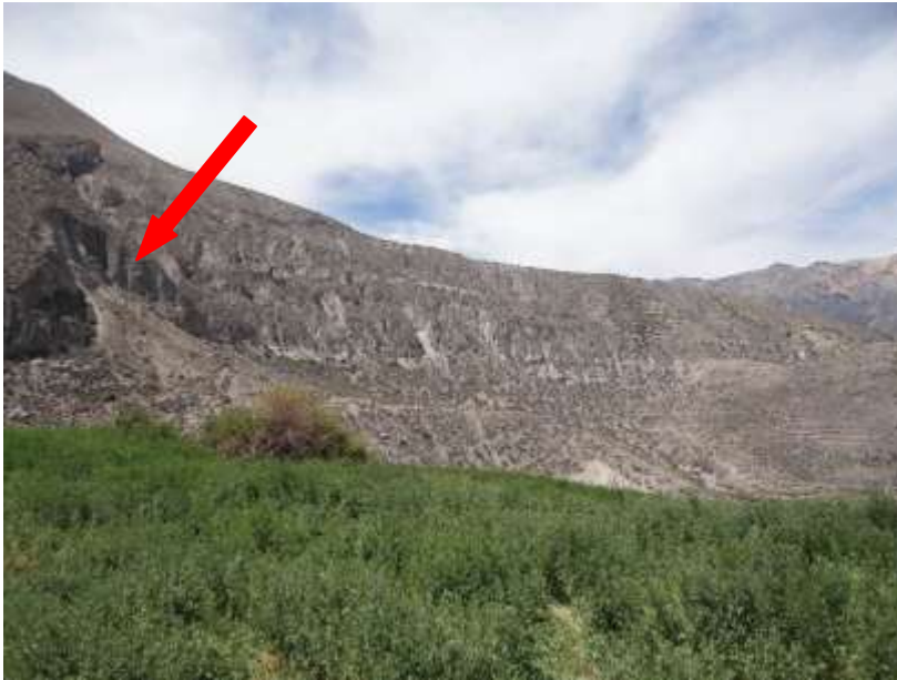
Figura 17: Zona de desprendimientos de rocas, colapso de ladera (derrumbes) y erosión en el sector Sacuaya viejo
