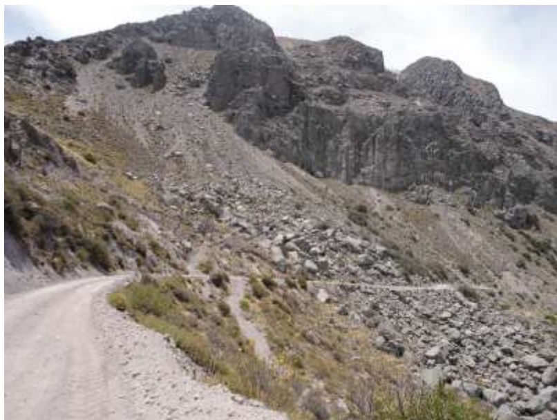
Figura 16: Desprendimientos y derrumbes de rocas en las cercanías de Querapi. Afecta la trocha carrozable que recorre el valle.
