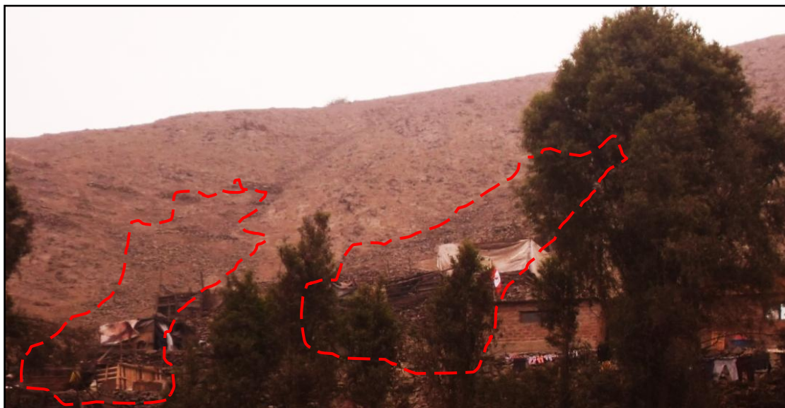
Figura 19: Las líneas segmentadas de color rojo nos muestran caída de rocas de 7” en los alrededores de la Zona el Lúcumo.
