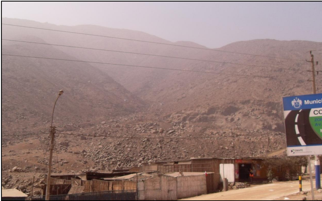
Figura 18: Depósito de flujo de detritos en las inmediaciones de la quebrada de la Zona “Q”.
