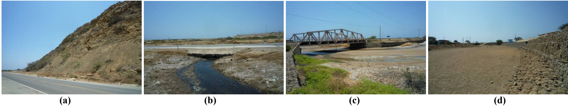
Panamericana Norte entre quebrada Bocapan y quebrada Plateritos. (a).- Derrumbes en talud superior de la Panamericana Norte. (b).- Flujos excepcionales por la quebrada Cardalito, pueden cortar la carretera. (c).- Flujos de detritos y erosión fluvial en la quebrada Palo Santo. (d).- Quebrada seca que se activa excepcionalmente, se han colocado gaviones en la margen derecha, sector Acapulco.
