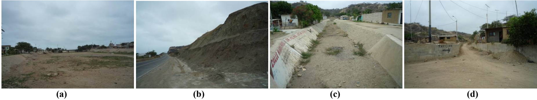
Panamericana Norte entre la Quebrada La Cruz y Zorritos. (a).- Quebrada LA Cruz por donde discurren flujos de lodo. (b).- Derrumbes en talud superior de la Panamericana Norte, sector cerro Loma Grande. (c).- Flujos de lodo excepcionales que discurren por torrenteras encauzadas, sector de Nueva Esperanza, a la altura del km 228+817 de la Panamericana Norte. flujos de lodo excepcionales en el poblado de Mechero Roci.
