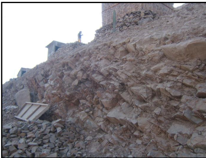
Foto 3.- Afloramiento Rocoso, se aprecia un sistema de fracturamiento contra talud.
