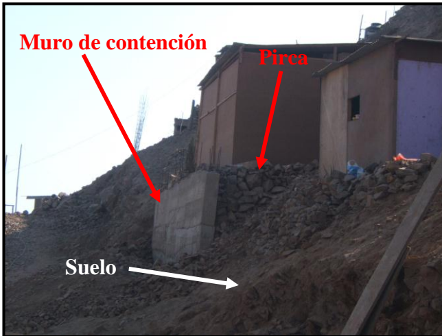
Foto 5.- Lote de la manzana “C”, muestra un muro de contención (?), y la pirca de 1.50 m.
