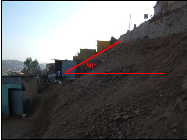
Foto 1.- Pendiente del terreno, que muestra el asentamiento humano y el material suelto.
