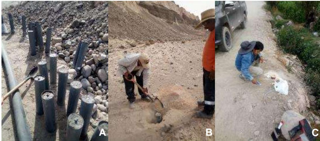
Figura 7. (A) Hitos de Concreto. (B) Instalación de hitos de concreto
