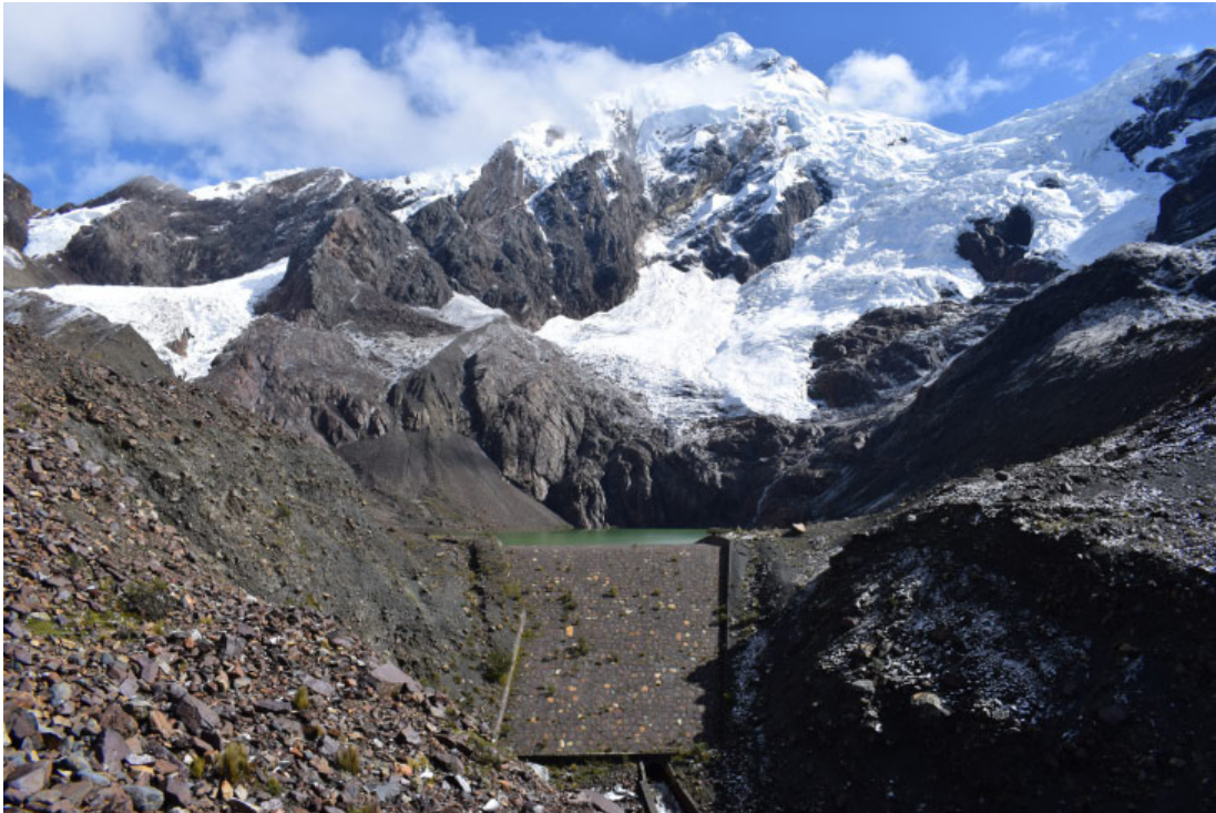
Fotografía 15. Dique de seguridad en la laguna Cuchillacocha.
