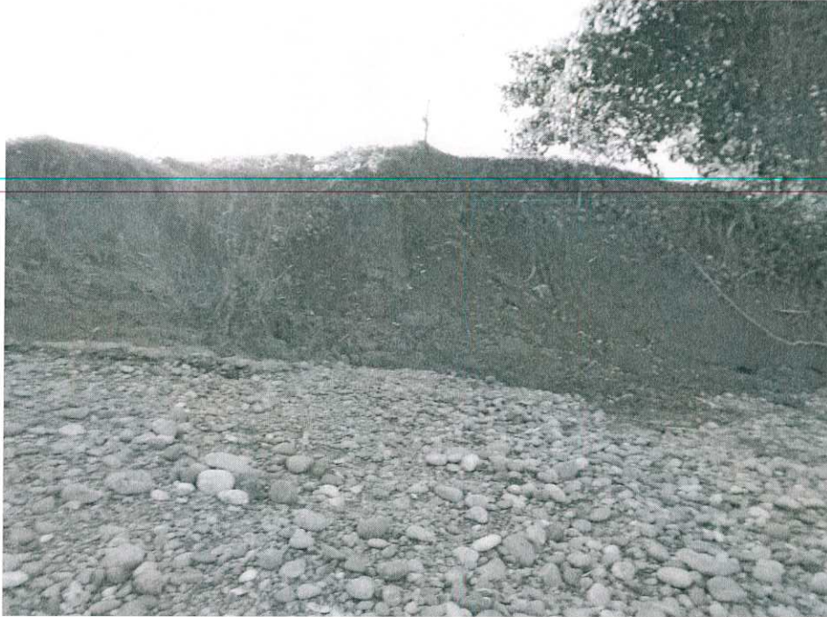
Erosión de la ribera del cauce del río.
