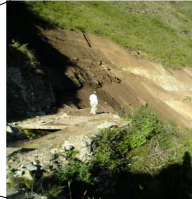
Zona de arranque del deslizamiento.
