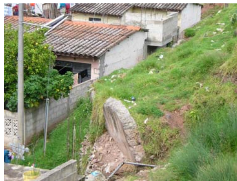
Foto – 38: Muros de concreto desplazados en 1997 no muestran movimientos recientes.
