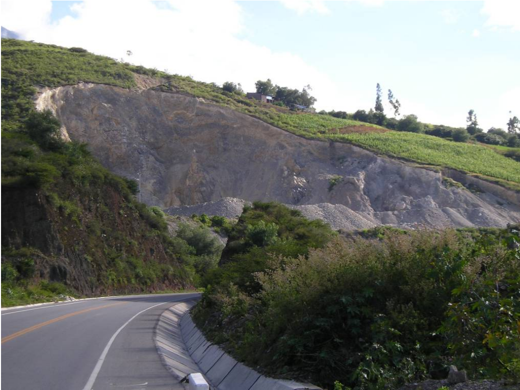
Foto – 18: Vista fotográfica del afloramiento rocas calcáreas (grupo Pucara) En el corte de talud de carretera.
