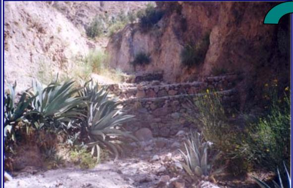
Parte alta de la quebrada Accopampa, en donde se observa muros para control de sedimentos totalmente colmatados,
