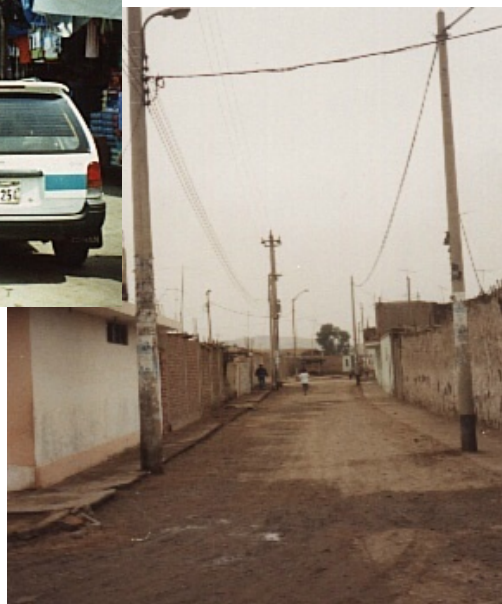
CALLE ESTRECHA SIN ASFALTAR – VIVIENDAS DE MATERIAL RÚSTICO Y MATERIAL NOBLE. PRESENCIA DE SALITRE – DISTRITO DE CERRO AZUL
