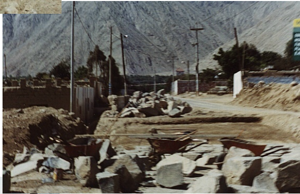
TRABAJOS DE ENROCADO Y BADEN
