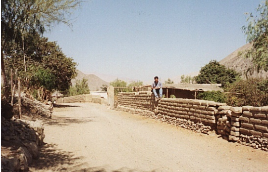
PROL. CALLE BOLVAR - SIN ASFALTAR Y VIVIENDAS DE ADOBE
