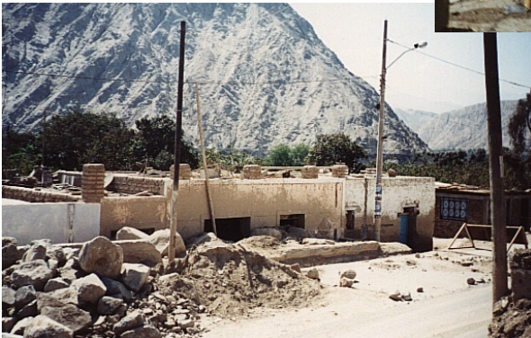
VIVIENDAS VULNERABLES A LOS HUAYCOS
