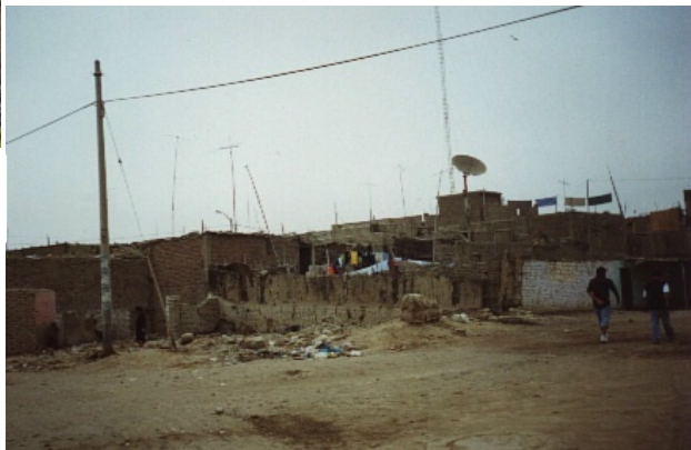
TUGURIZACIÓN, HACINAMIENTO CONSTRUCCIONES PRECIARIAS VULNERABLES A LA HUMEDAD Y SALINIDAD
