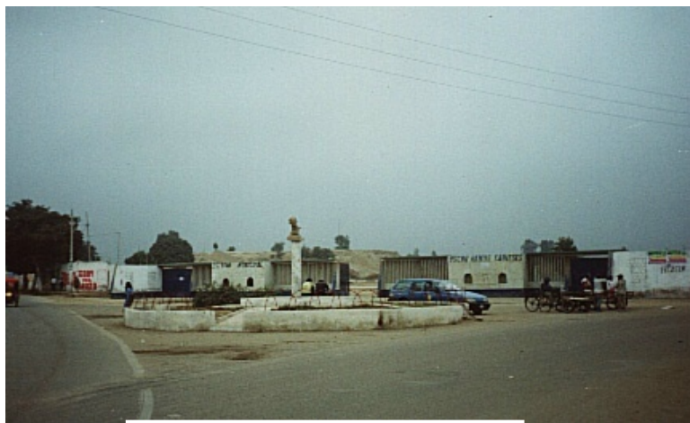
AV. BENIGNO RIOS - VIA QUE CONDUCE A NUEVO IMPERIAL - LUNAHUANA
