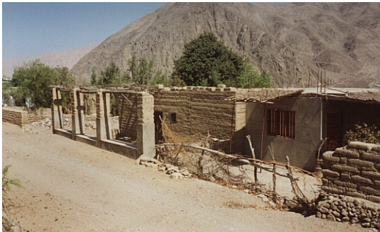
VIA DE ACCESO A LA CIUDAD SIN ASFALTAR
