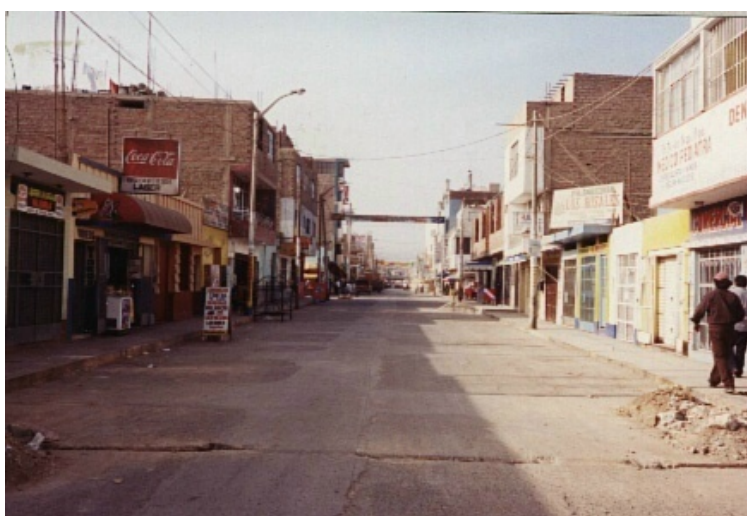
VIA EN EL AREA URBANA CON LA CARPETA ASFALTICA EN MAL ESTADO
