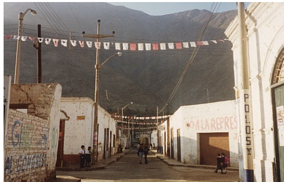
CALLE PRINCIPAL EN EL AREA URBANA. VIVIENDAS DETERIORADAS, AFECTADAS POR EL SALITRE
