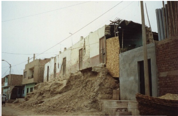
VIVIENDAS DE ADOBE SOBRE SUELOS DELEZNABLES. CON PRESENCIA DE HUMEDAD Y SALINIDAD
