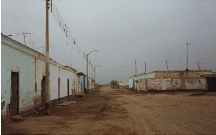
VÍA SIN ASFALTAR – VIVIENDAS DE MATERIAL RUSTICO
