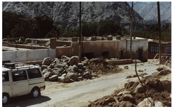
CARRETERA CAÑETE-LUNAHUANA Y VIVIENDAS DE ADOBE DETERIORADAS POR EL HUAYCO DE LA QUEBRADA SAN JERONIMO
