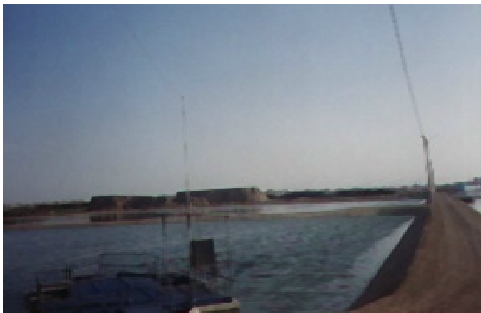
LAGUNA DE OXIDACIÓN
