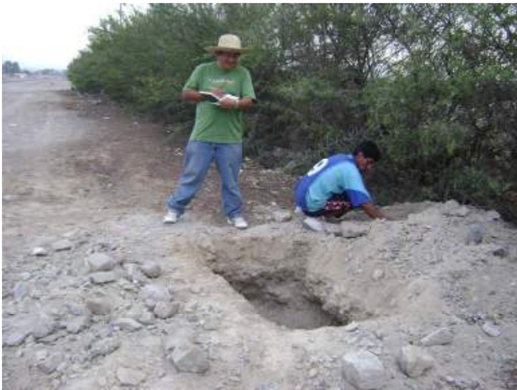
FOTO N° 02: Calicata N°04, ubicado al lado derecho de la carretera Chincha Alta-Alto Larán, a la altura de la UPIS Santa Ana de Alto Larán, nótese el material de arena mal graduada con limo y grava.
