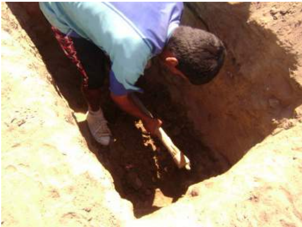
FOTO N° 04: Excavación de la Calicata N°10, ubicado en Grocio Prado, al lado izquierdo del canal Yataco, corresponde a un material areno limoso, no muestra piedras.
