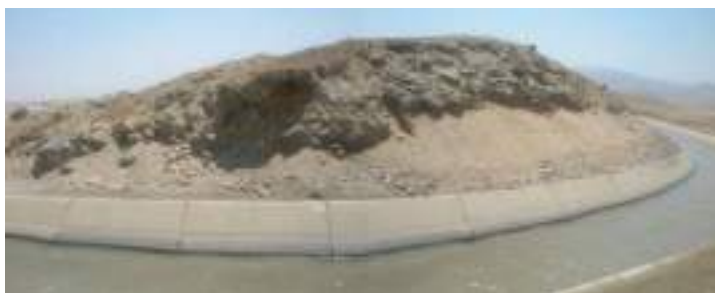
FOTO N° 03: Vista de gravas de depósito aluvial antiguo
