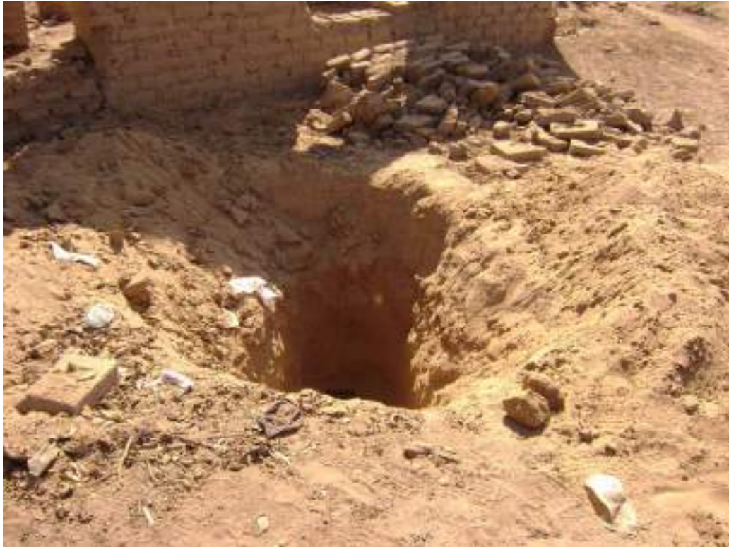
FOTO N° 03: Calicata N°09, ubicado en Grocio Prado, el material corresponde a un suelo areno limoso, que no contiene piedras.
