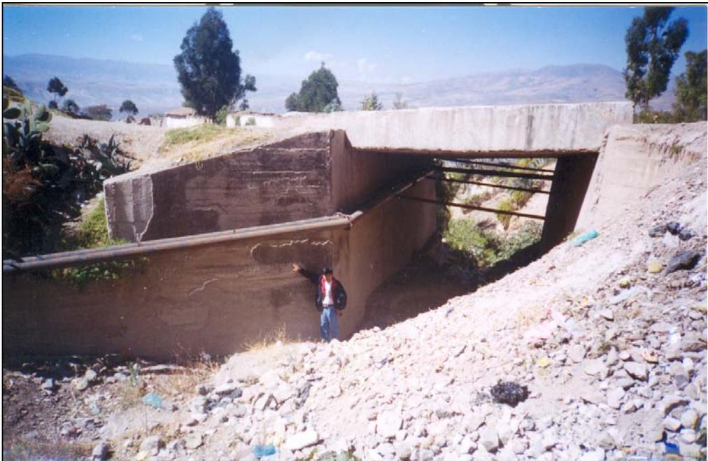
PUENTE EN LA VÍA LIBERTADORES WARI QUE DRENA LAS AGUAS DE LA QUEBRADA AQOPAMPA. PUNTO DE SITUACIÓN DE RIEGO CON FRECUENCIA BAJA.
