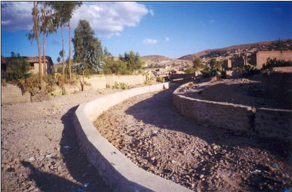
REDUCCIÓN DE LA SECCIÓN TRANSVERSAL DE LA QUEBRADA CHAQUIHUAYQO EN LA INTERSECCIÓN CON EL JR. AYACUCHO. PUNTO DE SITUACIÓN INMINENTE.
