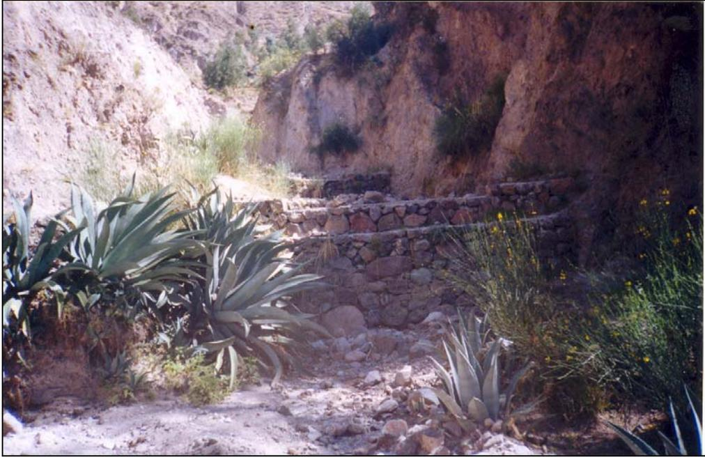
PARTE ALTA DE LA QUEBRADA AQOPAMPA. SE OBSERVA MUROS PARA CONTROL DE SEDIMENTOS TOTALMENTE COLMATADOS. PUNTO DE SITUACIÓN ALARMANTE.
