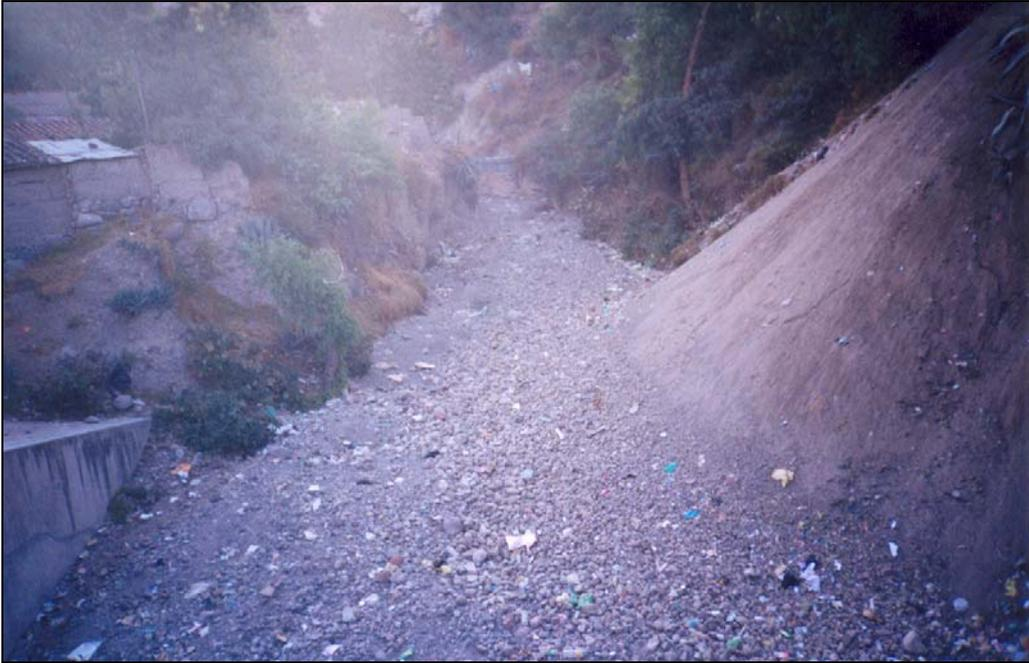
VISTA DESDE EL PUENTE UNIÓN. SE OBSERVA LA REDUCCIÓN DE LA SECCIÓN TRANSVERSAL DEL CAUCE. PUNTO DE SITUACIÓN DE ALTA PELIGROSIDAD
