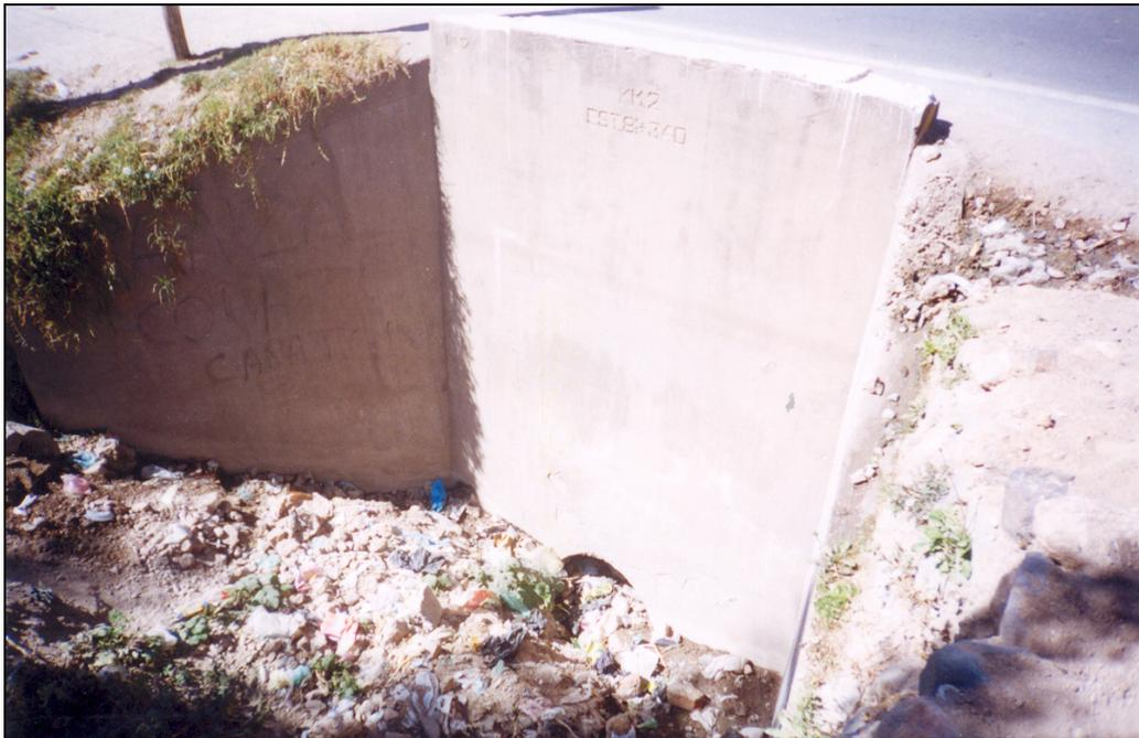
Alcantarilla de la Quebrada Yanaqaqa 3, colmatada por sedimentos. Punto de Situación alarmante.
