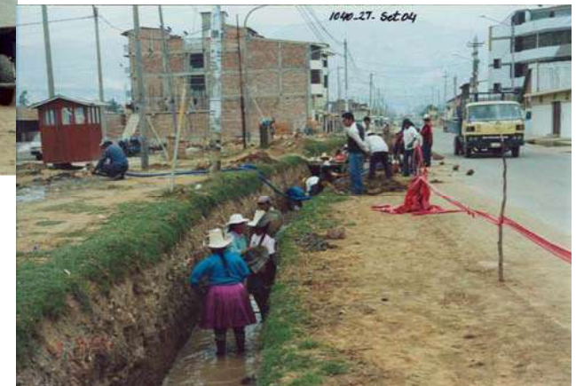
LA MISMA ZONA ANTERIOR CUANDO SE INCREMENTO DE PERSONAL DE TRABAJO PARA LIMPIEZA Y ENSANCHAMIENTO
