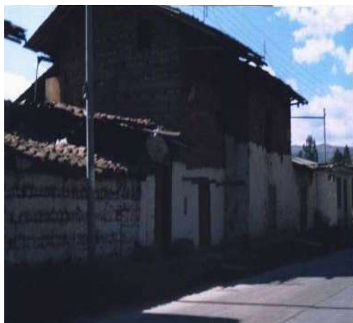
F-8SIS1 VIVIENDAS DE ADOBE (CARRETERA. A PUYLLUCANA)
