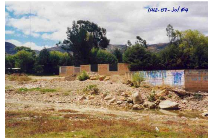
CAUCE Y MARGEN IZQUIERDA DEL RIO CHONTA CON ACUMULACIONES DE MATERIALES ALUVIO-FLUVIALES QUE SON UTILIZADOS COMO MATERIALES DE CONTRUCCION , TAMBIEN ENCONTRAMOS RESIDUOS SOLIDOS. LA EROSIÓN Y LA SOBRECARGA ESTAN AFECTANDO EL MURO PERIMETRICO DEL CLUB LOS INCAS
