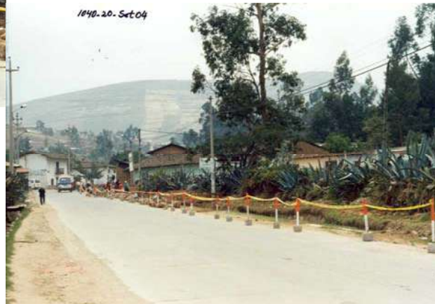
CANAL LAGUNA SECA CON TRAZOS PARA SU MEJORAMIENTO DEL CANAL
