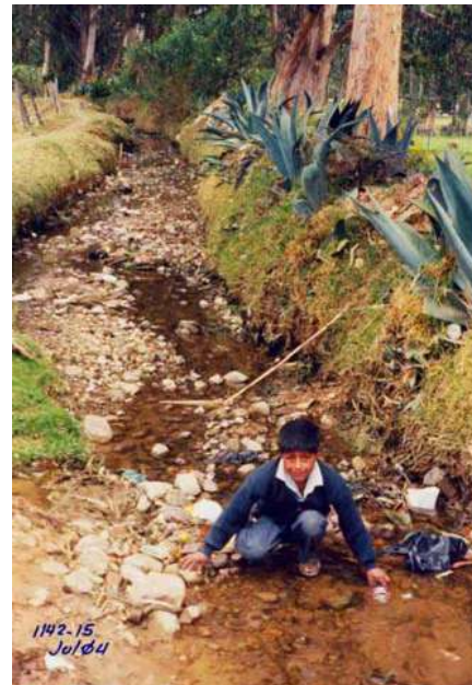
PARTE DEL CANAL REMONTA 2, CON FUERTE CONTAMINACIÓN POR LOS RESIDUOS ARROJADOS
