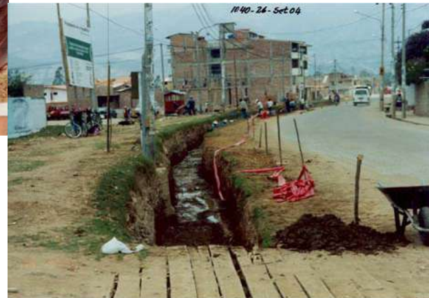
PANORAMICA DEL CANAL LAGUNA SECA EN EL SECTOR DE LOS BOMBEROS DONDE UNA CUADRILLA ESTÁ REALIZANDO LA LIMPIEZA Y ENSANCHE DEL CANAL
