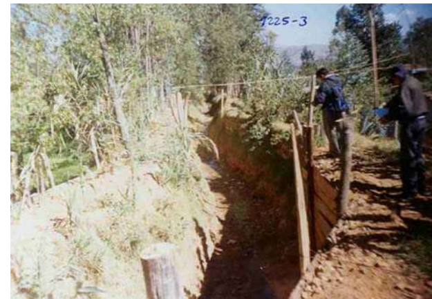
DEFENSA RIBEREÑA PROVISIONAL EN LA QUEBRADA TINGO MAYO
