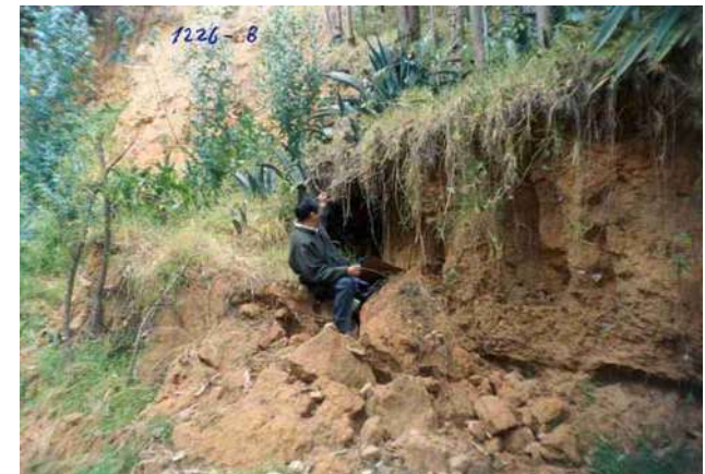
UNO DE LOS POCOS PUNTOS DONDE SE HA VISTO DERRUMBE DE UN TALUD CASI VERTICAL POR PROCESOS DE EROSION LATERAL Y EMPUJES ACTIVOS. NO REPRESENTA PELIGROS DE DESLIZAMIENTOS
