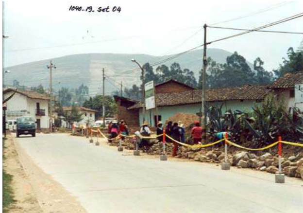
PERSONAL DEL PROGRAMA A TRABAJAR URBANO REALIZANDO LIMPIEZA Y ARREGLO DEL CANAL LAGUNA SECA, CERCA DE LA INTERSECCION CON EL CANAL REMONTA 2
