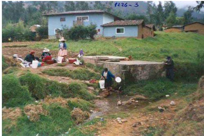
ZONA AFECTADA POR DESBORDES DE LA QUEBRADA SECA TINGO MAYO. SE OBSERVA UNA CAPTACIÓN DE AGUA SUBTERRANEA
