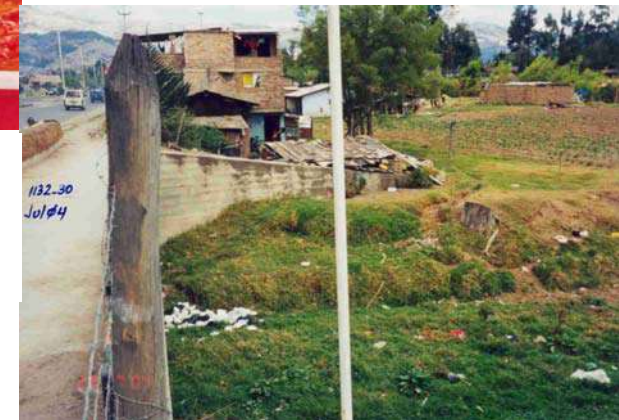
ACUMULACIÓN DE MATERIALES DE SEDIMENTACIÓN Y RESIDUOS SOLIDOS EN LA MARGEN DERECHA DEL RIO MASHCÓN EN LA INTERSECCION CON EL PUEBLO. TAMBIEN ES UNA ZONA DE INUNDACIÓN EN TIEMPOS DE FUERTES PRECIPITACIONES
