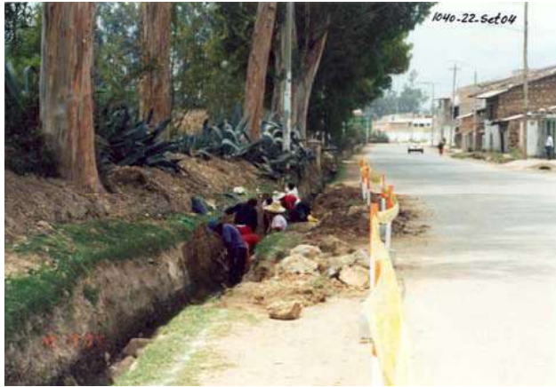
OTRO TRAMO EN PLENA LIMPIEZA
