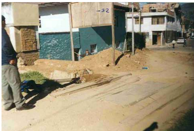
PARTE DE BAÑOS DEL INCA CERCADO AFECTADO POR INUNDACIONES
