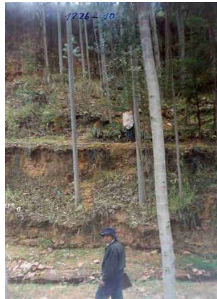
CONTROL DE EROSION DE LADERAS MEDIANTE EL CULTIVO DE EUCALIPTOS. HAN UTILIZADO EL METODO DE TERRACEO, LOGRANDO LA ESTABILIDAD DE PENDIENTES
