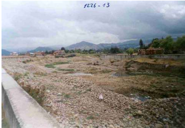
EXPLORACION DE AGREGADOS EN EL CAUCE DEL RIO CHONTA, PROCESO QUE AUMENTA LA RUGOSIDAD DEL LECHO
