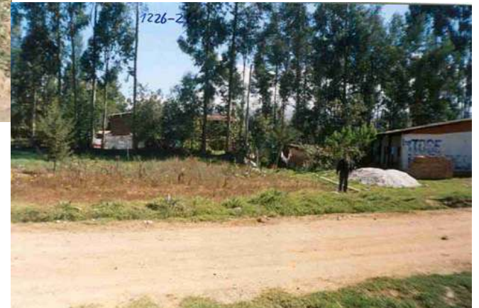
ZONA INUNDABLE POR DESBORDE DE LA QUEBRADA MAYOPATA, UBICADA JUNTO AL JR. LIBERTAD Y EL JR. GUADALUPE
