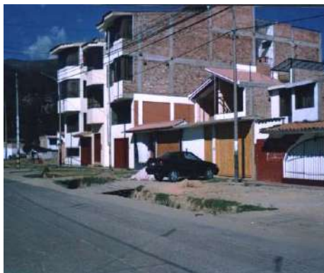
F-8S14 VIVIENDAS DE 5 PISOS EN LA AV. MANCO CAPAC
