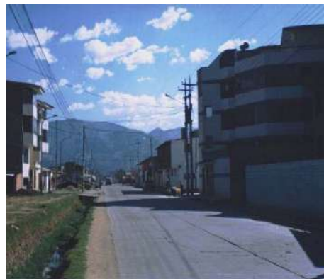
F-8S155 VIVIENDAS DE 5 PISOS EN LA AV. MANCO CAPAC
