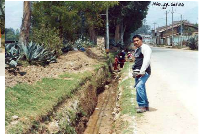
PERSONAL DE A TRABAJAR URBANO EN LABORES DE LIMPIEZA DEL CANAL
