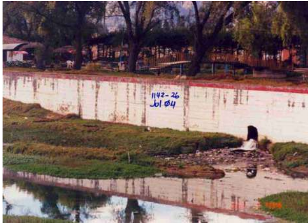
PUNTOS DE DESCARGAS DE AGUAS SERVIDAS Y AGUAS DE LAS PISCINAS TEMPERADAS
