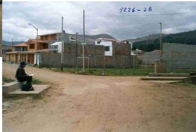
URBANIZACIÓN LAGUNA SECA QUE SE INUNDA CONSTANTEMENTE POR DESBORDE DE LA QUEBRADA SECA TINGO MAYO
