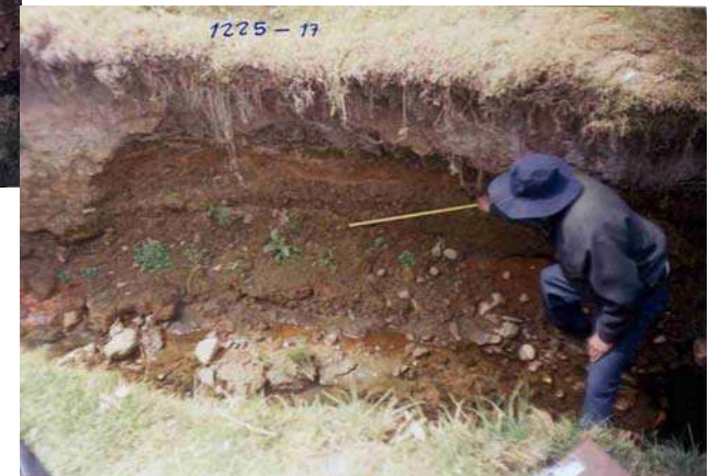
EROSION LATERAL Y DE FONDO EN EL CANAL LAGUNA SECA. VISIBLE LA ESTRATIGRAFIA DE DEPOSITOS ARCILLOSOS CON MATERIALES ORGANICOS Y PRESENCIA DE LIMONITAS UBICACIÓN CERCANA A LA INTERSECCION CON EL CANAL REMONTA 2
