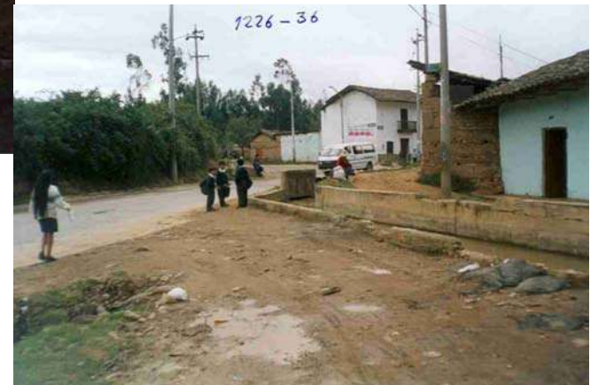
PUNTO CRITICO DE DESBORDES DEL CANAL REMONTA 2, DENTRO DE BAÑOS DEL INCA CERCADO
