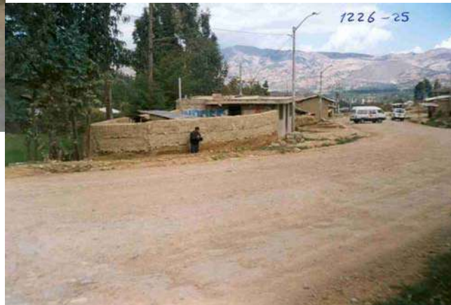
ZONA INUNDABLE EN PUYLLUCANA DEBIDO AL DESBORDE DEL CANAL LUICHUPUCRO-PUYLLUCANA QUE PASA POR UN COSTADO DE LA CARRETERA
