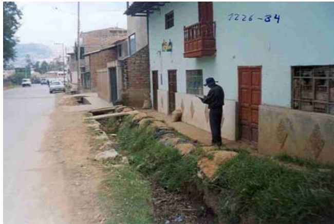
DRENAJE EN MALAS CONDICIONES QUE PASA POR LA AV. MANCO CAPAC. LOS MORADORES SE PROTEGEN DE LOS DESBORDES UTILIZANDO SACOS CON ARENA
