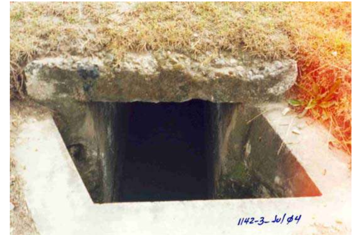
CANAL CERRADO DEBAJO DE LA CARRETERA CAJAMARCA – BAÑOS DEL INCA. SU RECORRIDO ES HACIA EL RIO CHONTA
