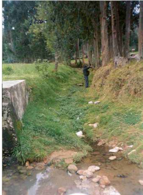
TRAMO SEDIMENTABLE AGUAS ARRIBA DEL PUNTO DE DESBORDE DE LA QUEBRADA SECA TINGO MAYO
