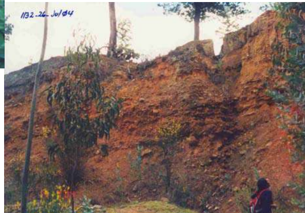
TALUDES EN LA QUEBRADA TINGO MAYO, EN LA ZONA ESTE DE SHAULLO, CON PENDIENTES CASI VERTICALES HASTA 60°, FUERTEMENTE METEORIZADAS Y LIMONITIZADAS. SE ENCUENTRAN CERCA DEL LIMITE ESTE DEL AREA DE ESTUDIO Y PRESENTAN CONDICION SEMIESTABLE. A ESTABLE
