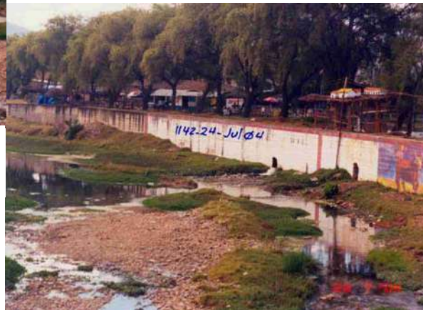
MARGEN IZQUIERDA DEL RIO CHONTA, PRESENCIA DE AGUAS NEGRAS FETIDAS, BASURA NO BIODEGRADABLE, ASI COMO PUNTOS DE EMISION DE AGUAS DE DESAGUE, AGUA DE LA LAGUNA Y PISCINAS
