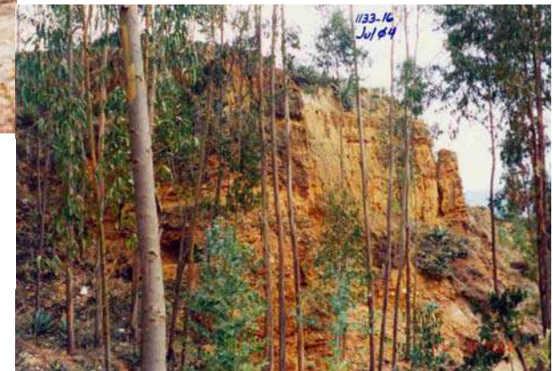
ESCARPAS DESDE VERTICALES HASTA 55° EN LA FORMACIÓN CARHUAZ, ESTABLES A SEMIESTABLES, FUERTEMENTE LIMONITIZADAS, PRESENCIA DE EUCALIPTOS QUE LOGRAN BUENA ESTABILIDAD
