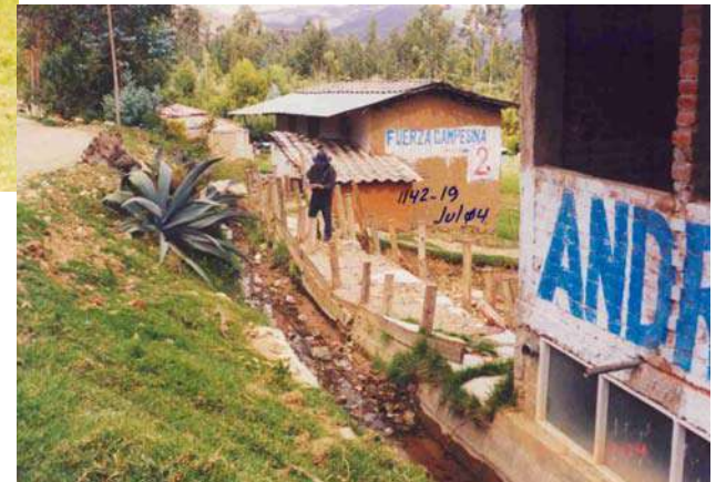
CANAL REMONTA 2 PARALELO A LA CARRETERA QUE CIRCUNDA A BAÑOS CERCADO. SU RASANTE ESTA MUY POR ENCIMA DE LOS TERRENOS DE SU MARGEN DERECHA
