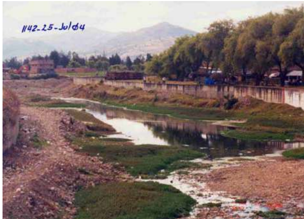
CAUCE DEL RIO CHONTA CON AGUAS NEGRAS ESTANCADAS ASI COMO SEDIMENTACIÓN DE MATERIALES ALUVIO.FLUVIALES
