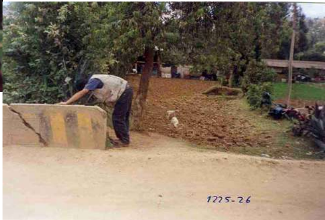
ZONA INUNDABLE POR DESBORDE DE LA QUEBRADA MAYOPATA
