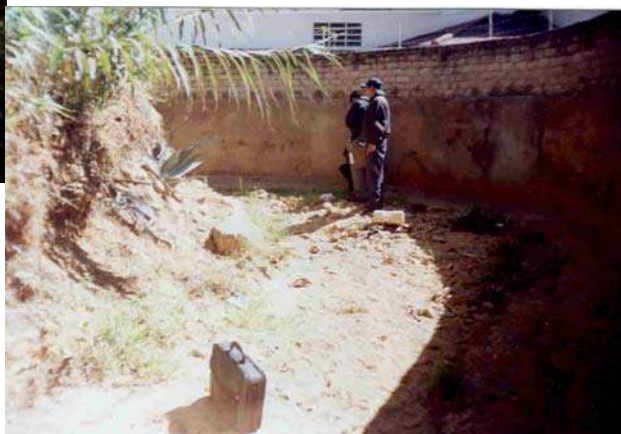
CANALIZACIÓN DE LA QUEBRADA SECA TINGO MAYO, AL COSTADO DEL HOSTAL LAGUNA SECA
