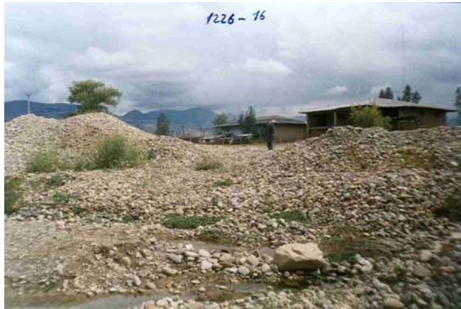
MARGEN DERECHA DEL RIO CHONTA POR DONDE PUEDE OCURRIR DESBORDES E INUNDACIONES EN LA URB. HURTADO MILLER
