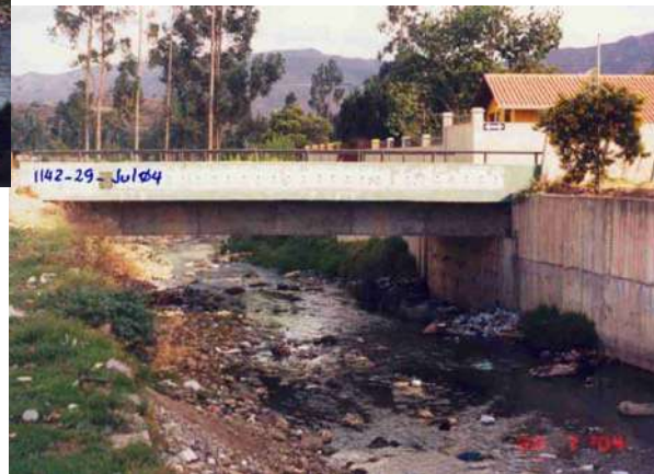
CAUCE DEL RIO CHONTA MIRANDO HACIA EL SUR, COMPLETAMENTE CONTAMINADO
