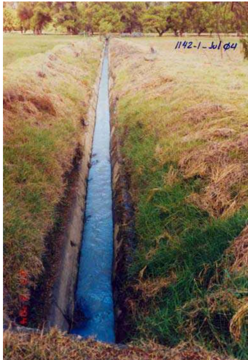
CANAL DE TRANSPORTE DE RESIDUOS LIQUIDOS DE LA FABRICA GLORIA, CON FUERTES OLORES DE SUSTANCIAS DESCOMPUESTOS. DESDE LA FABRICA HASTA CERCA DE LA CARRETERA CAJAMARCA – BAÑOS DEL INCA
