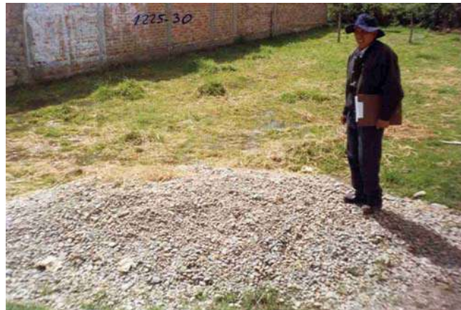
ZONA INUNDABLE UBICADA EN LA EXPANSION URBANA A UN COSTADO DEL CANAL REMONTA 2
