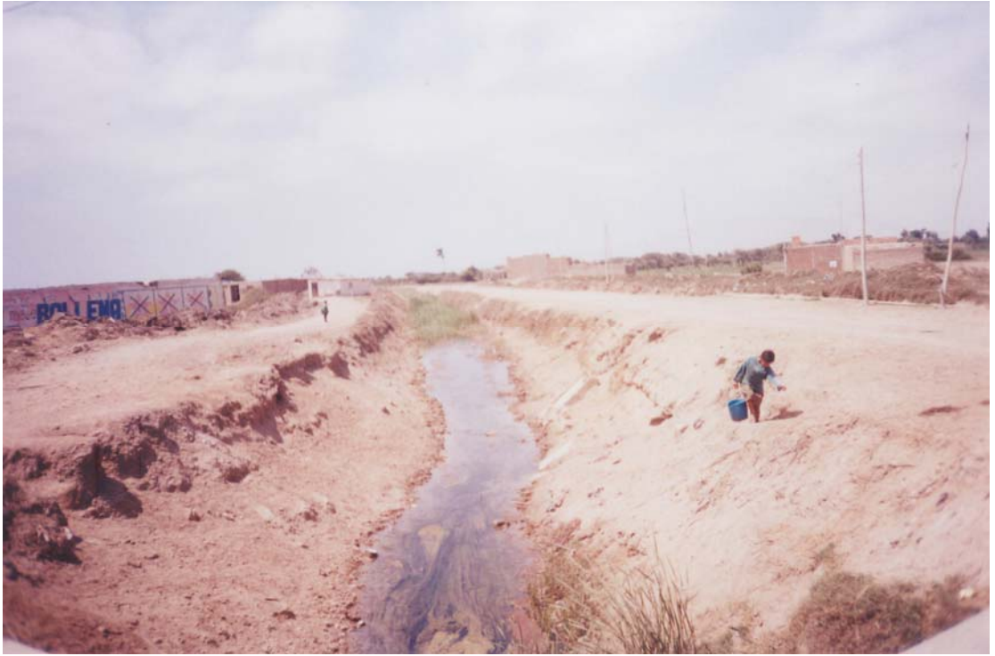
Vista del dren 5000
