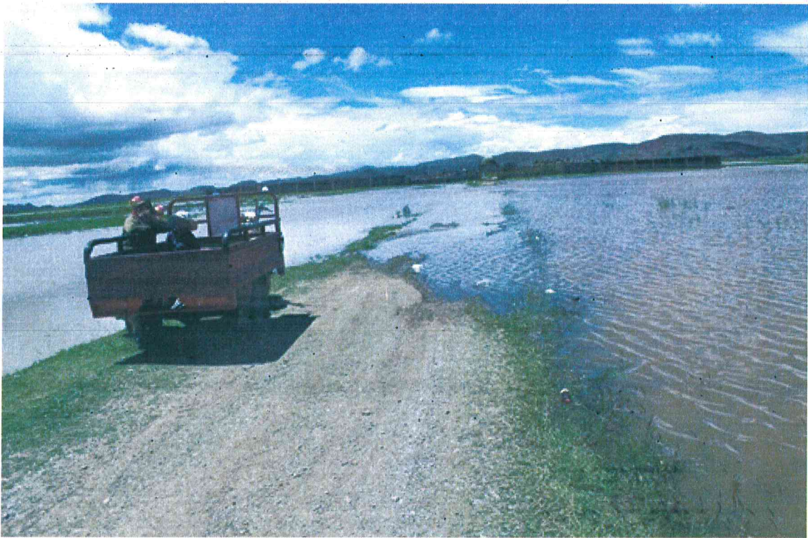
Imagen 03 – Inundación del Rio Coata – Accesos vial al Cementerio Inundado.
