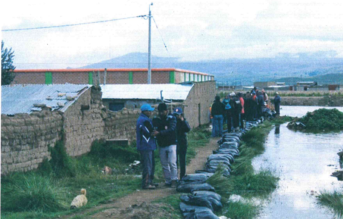
Imagen 02 – Inundación del Rio Cabanillas – Defensa con sacos terreros - Provincia de Lampa.
