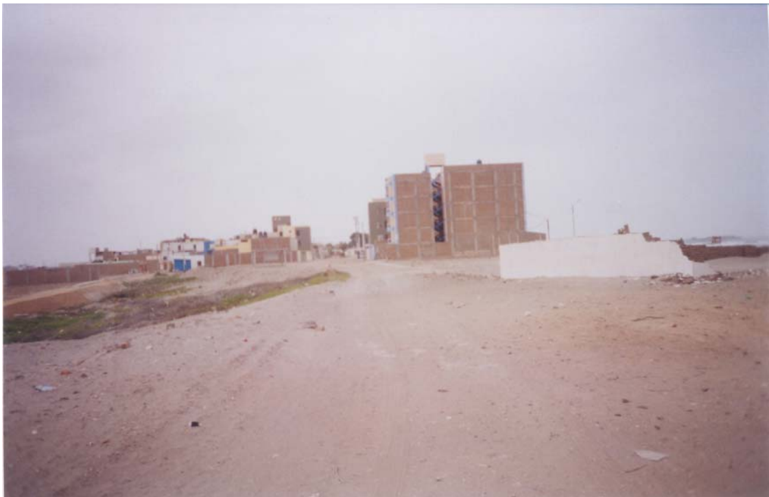
Vista de Pimentel, zona nor-oeste, cerca al dren que va al mar
