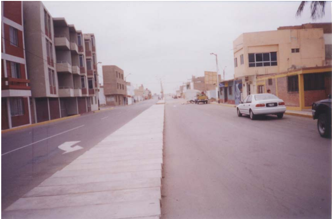
Vista de la Av. Alfonso Ugarte, zona de inundación
