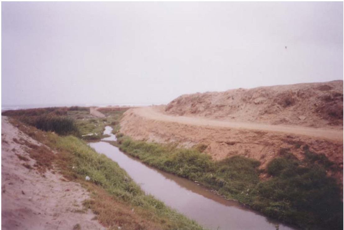
Vista de Evacuación del dren al mar
