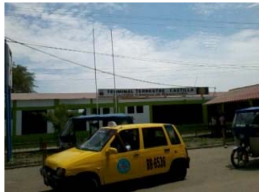
Terminal Terrestre Castilla
