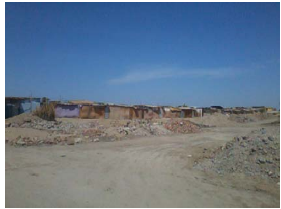
Invasión A.H. Trelles Lara, sobre terrenos depresivos e inundables por la Laguna Santa Julia
