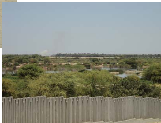
Zona de filtraciones por la laguna de oxidación El Indio
