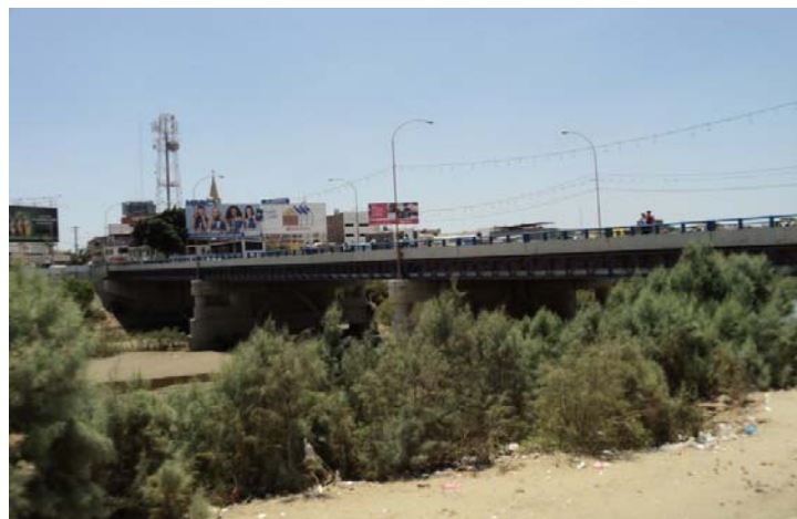
Puente Sánchez Cerro
