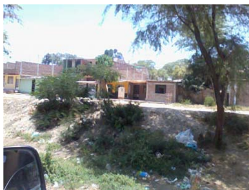
A.H. y Dren 18 de Mayo - Presenta erosión.
