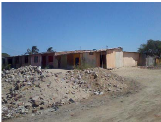
A.H. 31 de Enero ubicado en terreno depresivo e inundable por la Laguna Santa Julia
