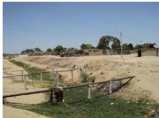
Dren El Indio
